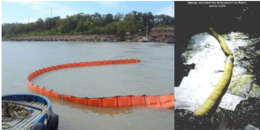
Figure 1 : Installation d'un barrage flottant ( http://www.flexitankchina.fr ) / Barrage absorbant ( cedre.fr )
