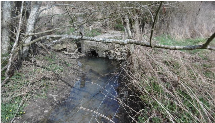
Photo 14: Ouvrage affaissé sur le ruisseau des Bouxy.
