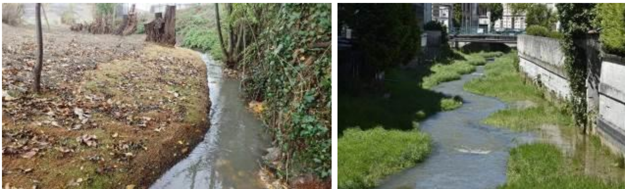
Figure 12 : Aménagements de banquettes sur le Charlet (63) et les canaux de Verdun (55)
