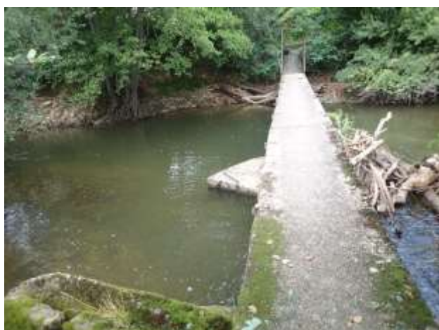
Figure 34 : Erosion au pieds des piles de la passerelle
