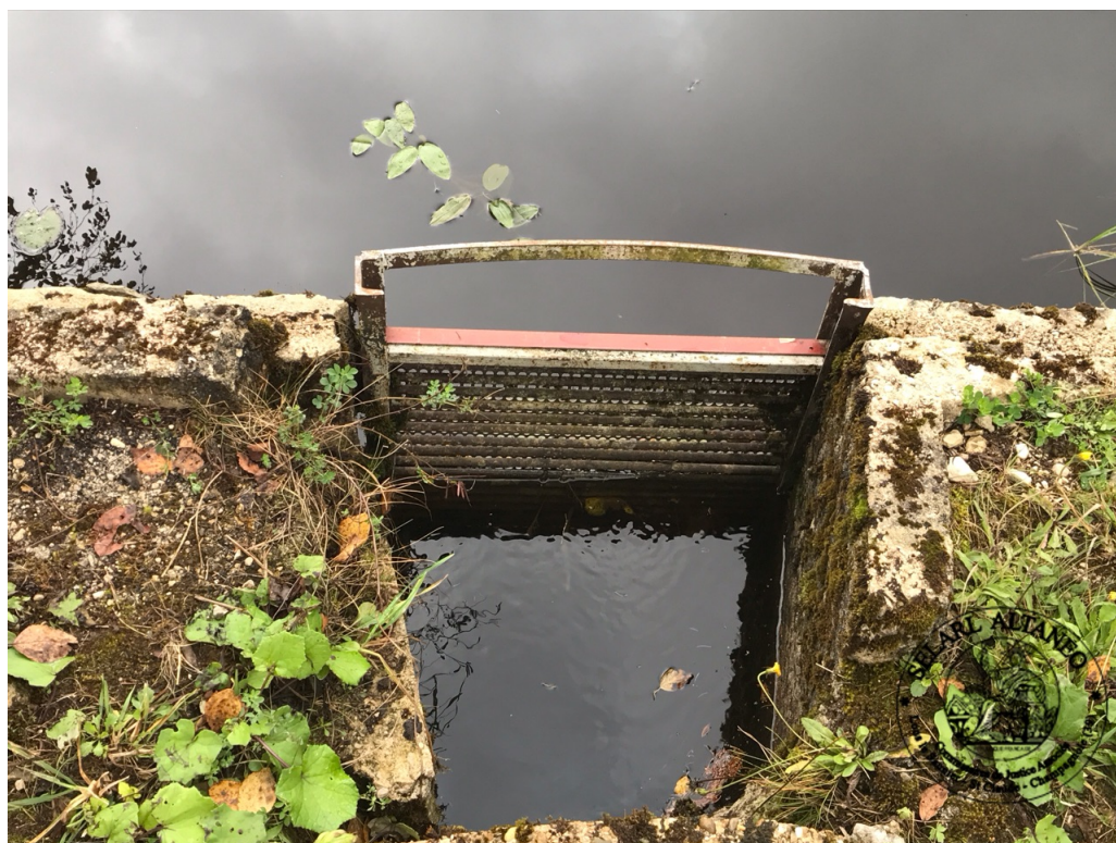
7. Vue de l'évacuation droite avec grille faite de barreaux horizontaux sur laquelle est scellée et soudée une grille en galvanisé perforé (10:33:10)
