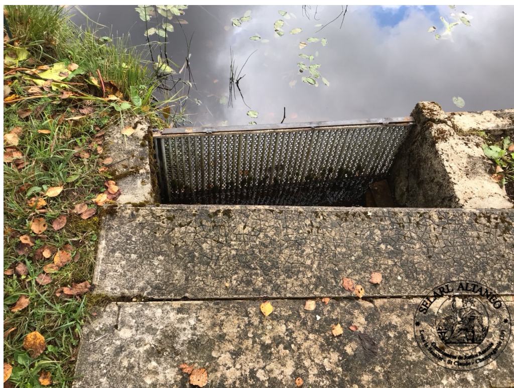
5. Vue de l'évacuation gauche avec grille faite de barreaux verticaux sur laquelle est scellée et soudée une grille en galvanisé perforé (10:31:31)
