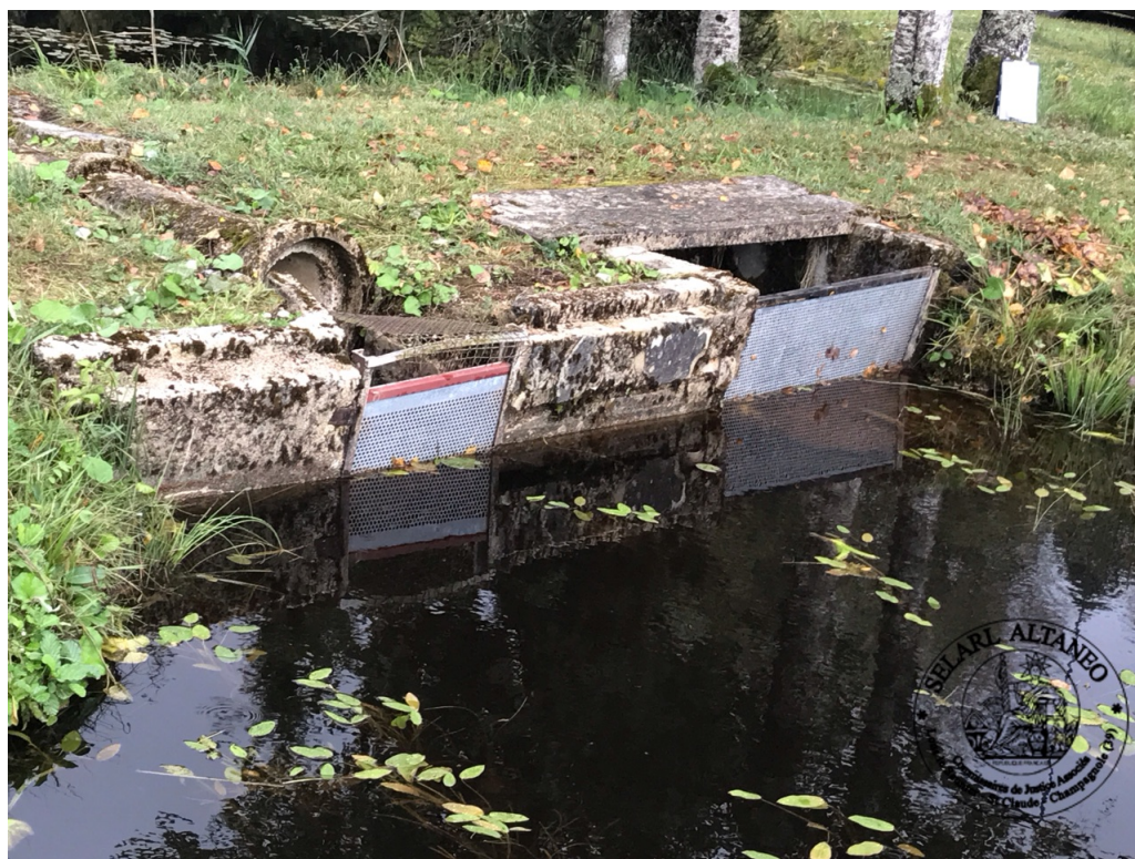
9. Vue de la grille en galvanisé perforé, scellée et soudée sur la grille en barreaux de chaque évacuation (10:32:10)
