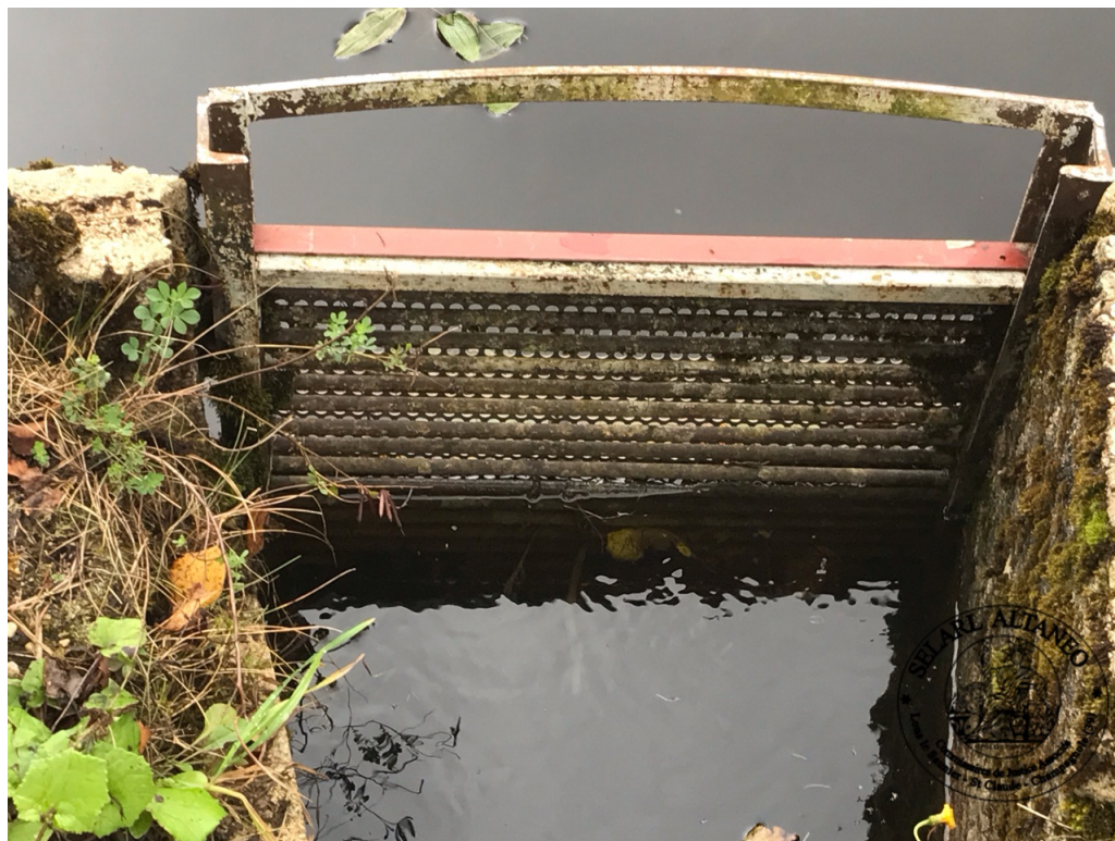
8. Vue de l'évacuation droite avec grille faite de barreaux horizontaux sur laquelle est scellée et soudée une grille en galvanisé perforé (10:33:17)
