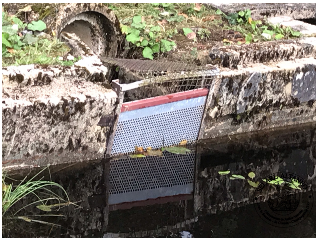
10. Vue de la grille en galvanisé perforé, scellée et soudée sur la grille en barreaux de chaque évacuation (10:32:14)
