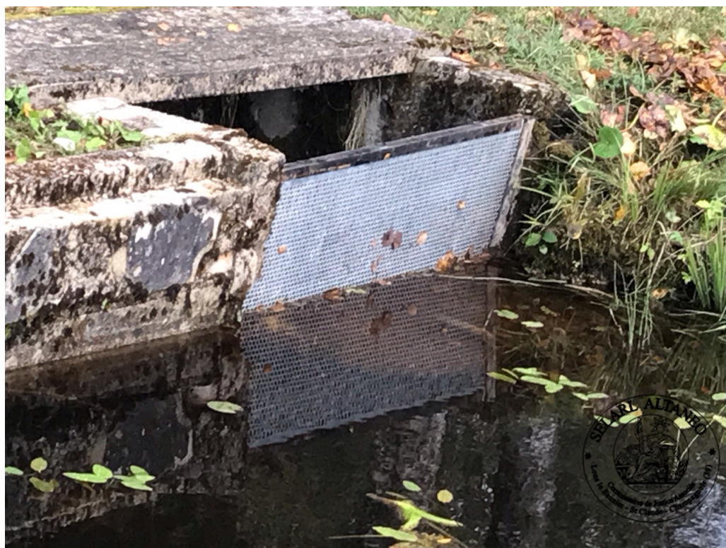
11. Vue de la grille en galvanisé perforé, scellée et soudée sur la grille en barreaux de chaque évacuation (10:32:17)
