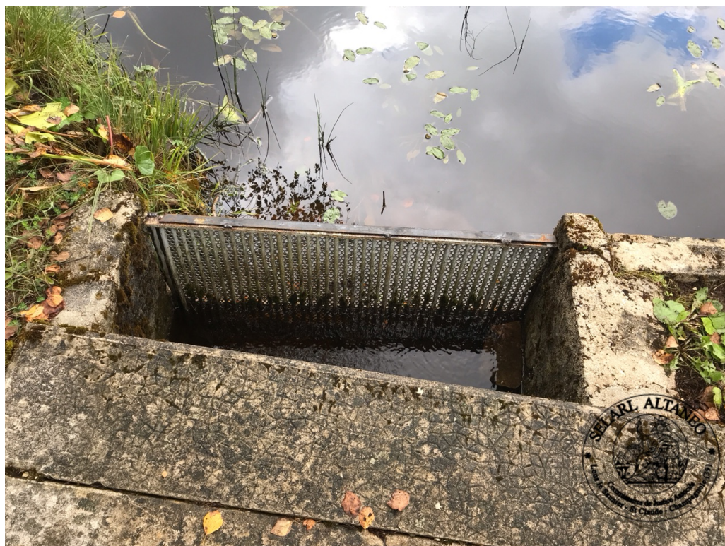
6. Vue de l'évacuation gauche avec grille faite de barreaux verticaux sur laquelle est scellée et soudée une grille en galvanisé perforé (10:31:55)
