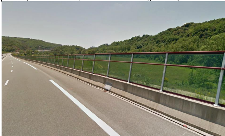
Figure 15 : Exemple de protection acoustique sur l'A75
