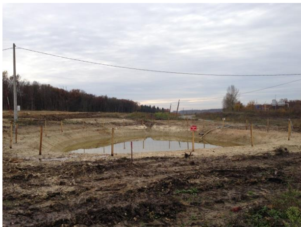
Exemple de bassin de décantation en phase travaux
