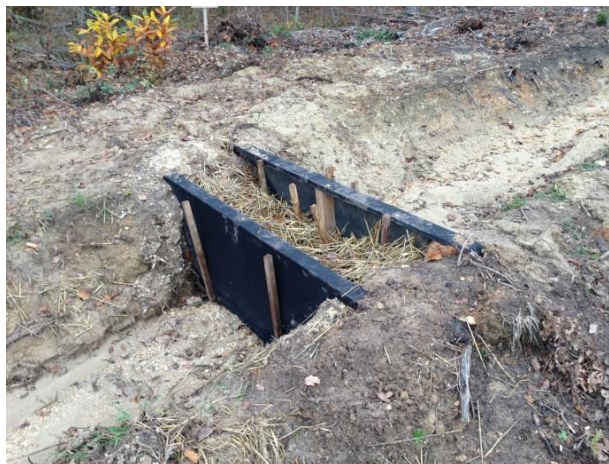
Exemple de filtre à paille en phase travaux
