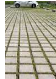
Pavés béton avec joints enherbés
