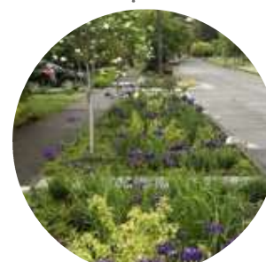
Une noue permettant l'infiltration des eaux pluviales
