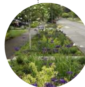
Une noue permettant l'infiltration des eaux pluviales
