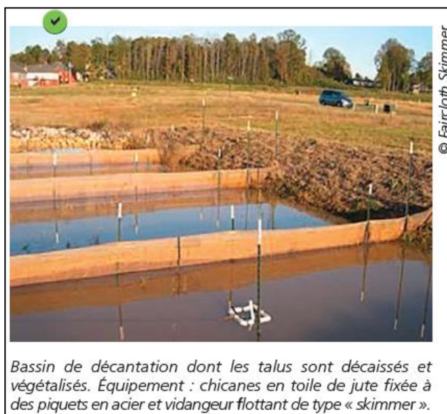
Figure 40 : Illustration de filtres géotextile fixés sur piquets
