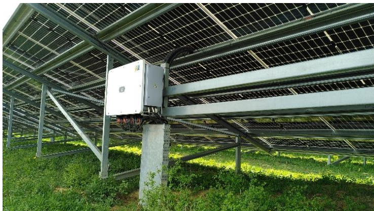
Figure 6: Exemple d'onduleur accroché derrière les tables de modules
