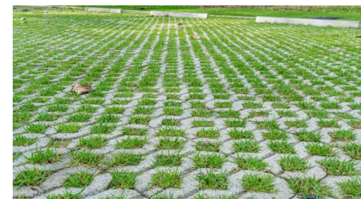
Figure 70: Exemple de parking en dalle engazonnée (Evertop)
