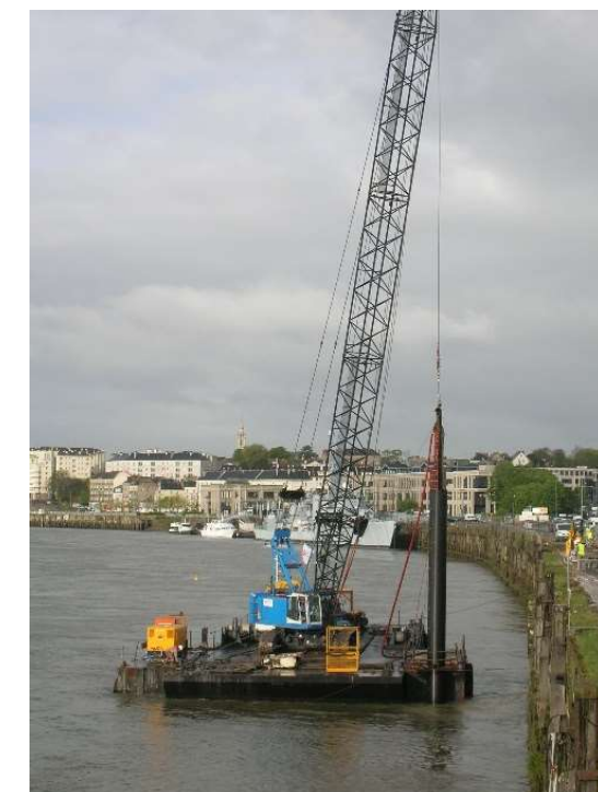
Figure 71: Exemple de plateforme flottante pour le battage des pieux
