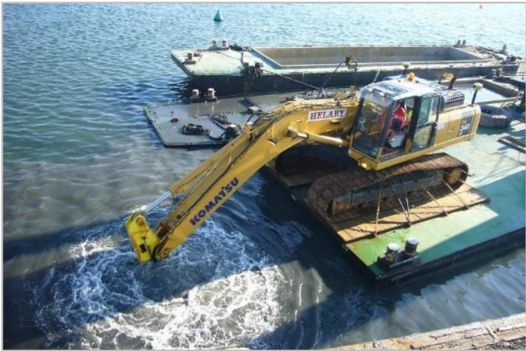
Figure 54 : Panache turbide créé autour de l'engin d'extraction [IDRA]
