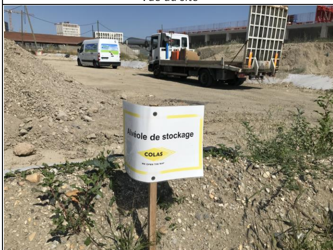
Alvéole de stockage sur site
