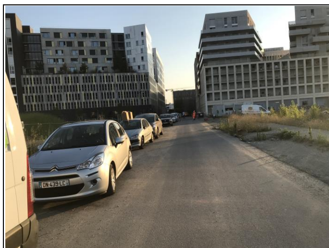
Route d'accès au chantier
