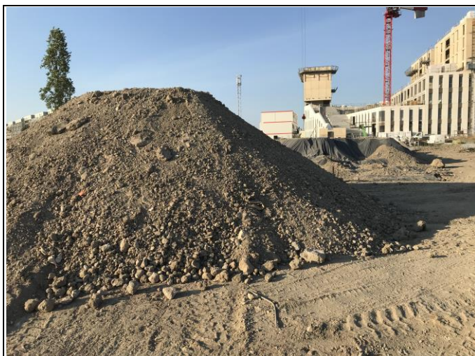
Alvéole de stockage sur site
