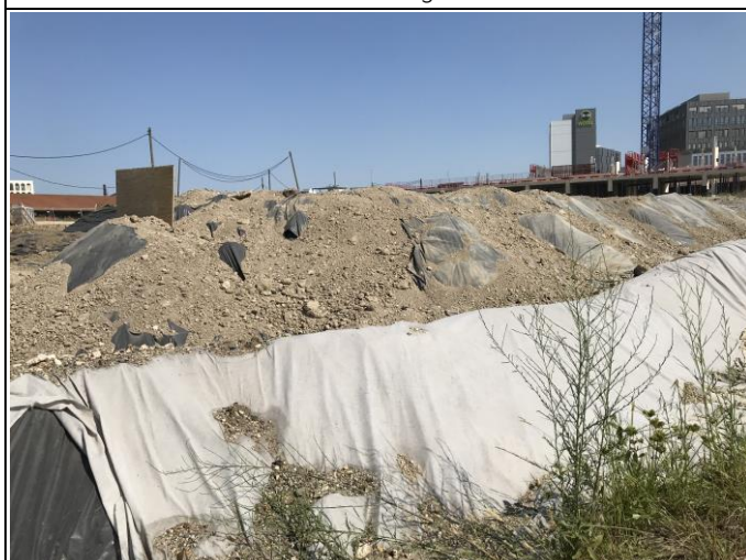
Alvéole de stockage sur site
