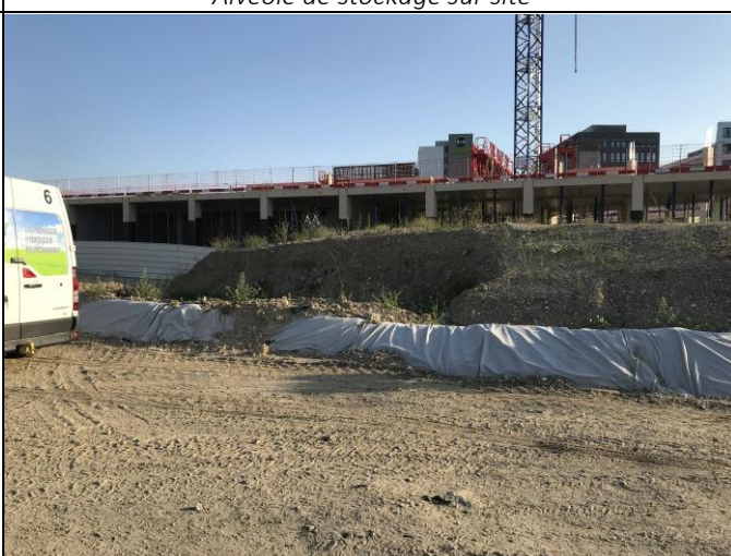
Alvéole de stockage sur site
