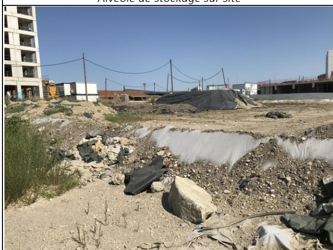
Alvéole de stockage sur site
