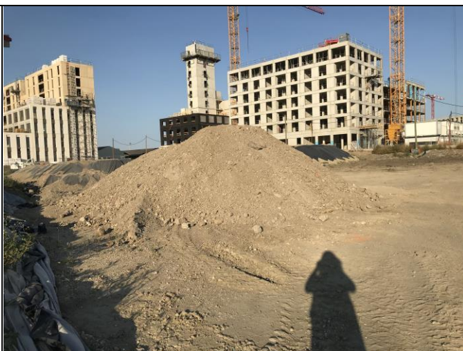
Alvéole de stockage sur site
