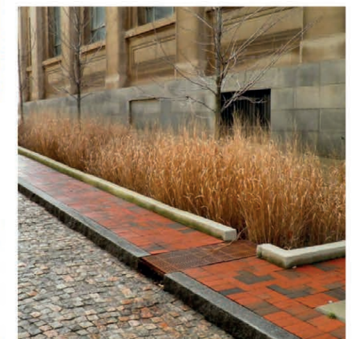
Jardin de Pluie, Chicago (US) Même en milieu urbain dense, un trottoir peut accueillir un massif de rétention dans des espaces verts en creux. Source : PINTEREST
