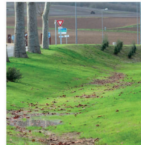
Noue d'infiltration simple Les noues peuvent prendre la forme de large surface enherbée évasée. Source : CHAMP LIBRE
