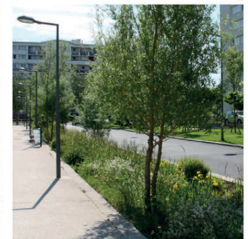
Noue drainante Quartier du Plateau à Ris Orangis. La palette végétale doit être adaptée à la nature drainante du substrat et à la faible quantité de terre végétale. Source : SOSSON Paysages
