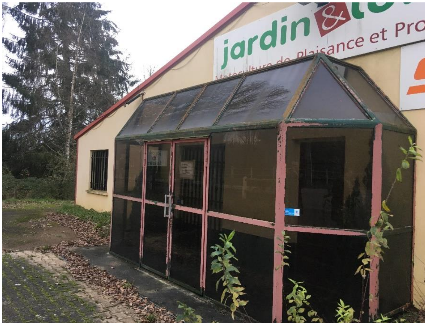
Photographie 6 : Bâtiment de motoculture allant être démolli
