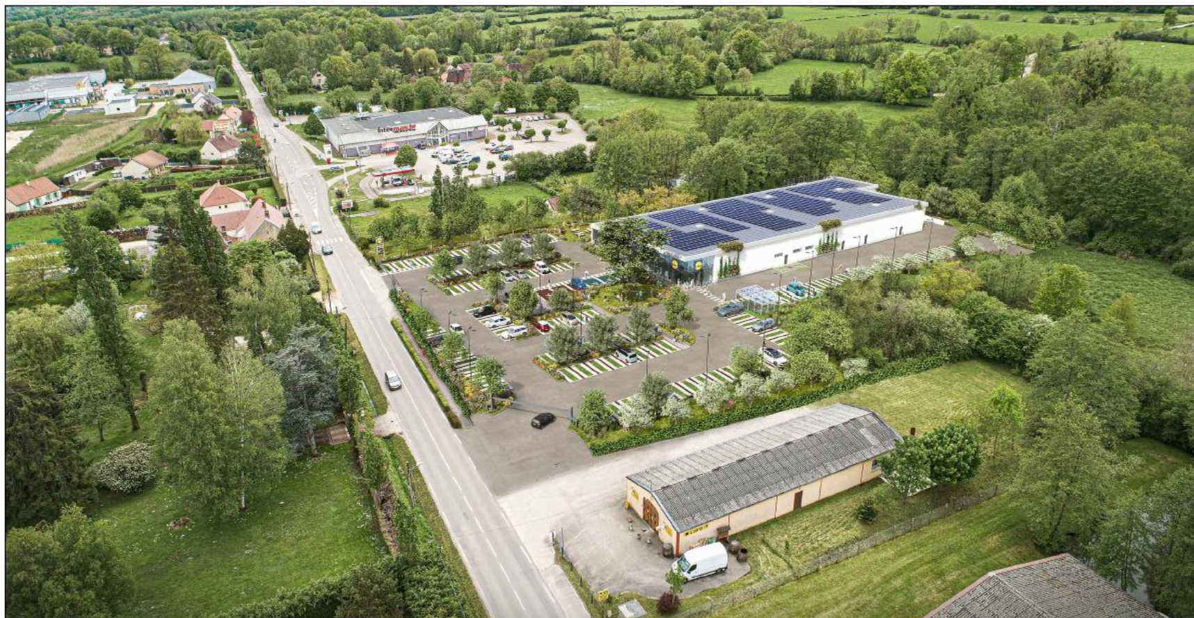
Figure 6 : Vue aérienne du projet
