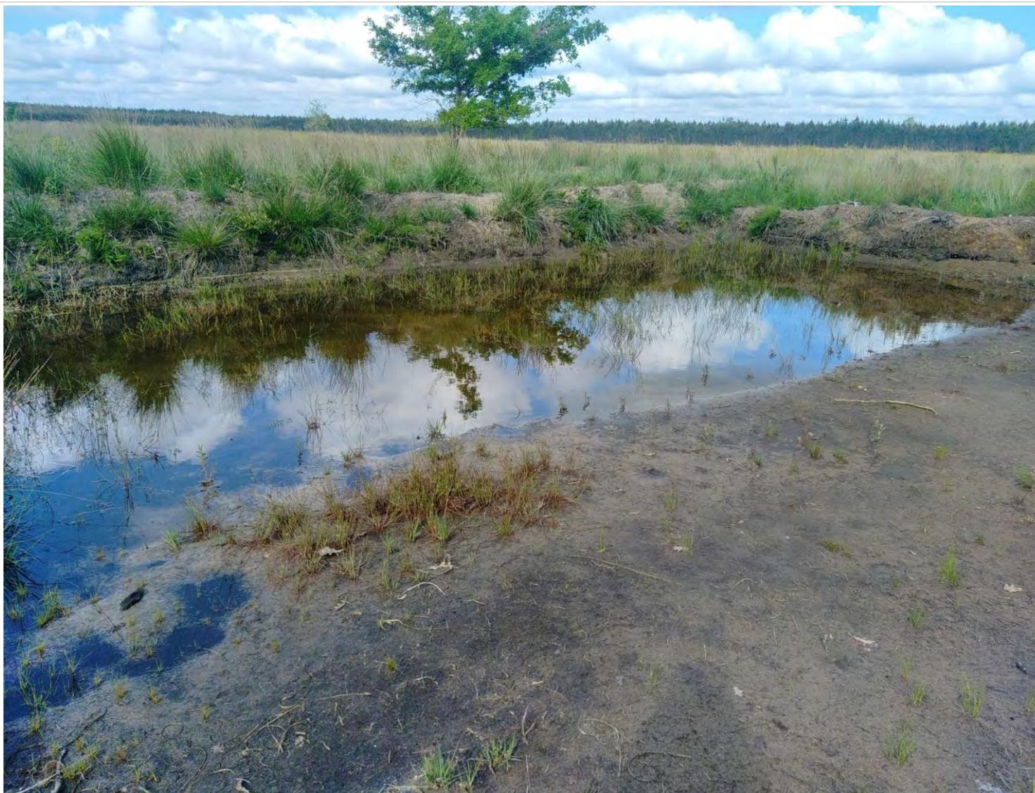
Exemple de **travaux d'étrépages/décapages** dans un contexte landicole (illustration du résultat à obtenir dans le cadre de la compensation « zones humides »)
