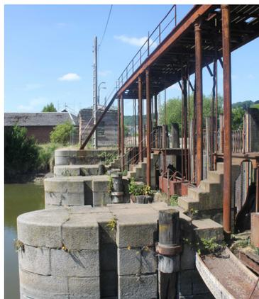
L'écluse des «bassins de chasse» construit pour lutter contre l'envasement du port.
