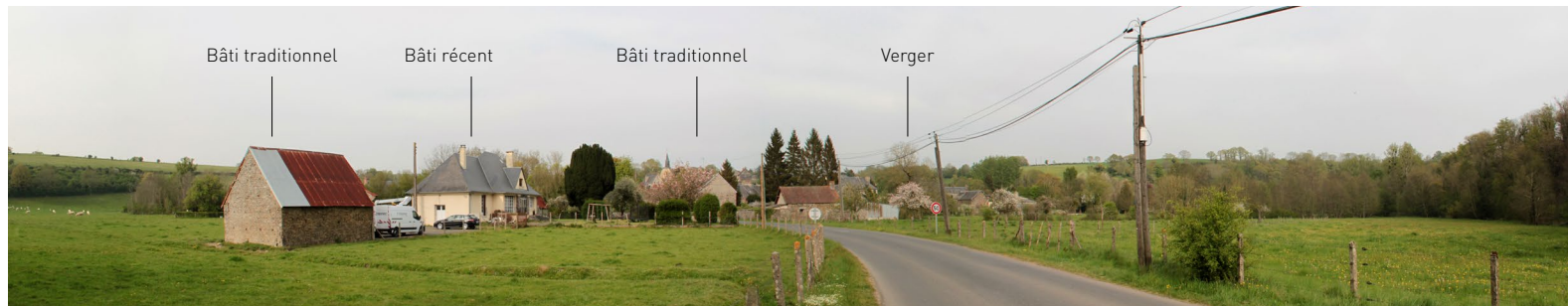
Valdallière - Le Theil-Bocage : Des constructions récentes implantées au sein des hameaux historiques, volumes identiques mais matériaux et teintes contrastés.
