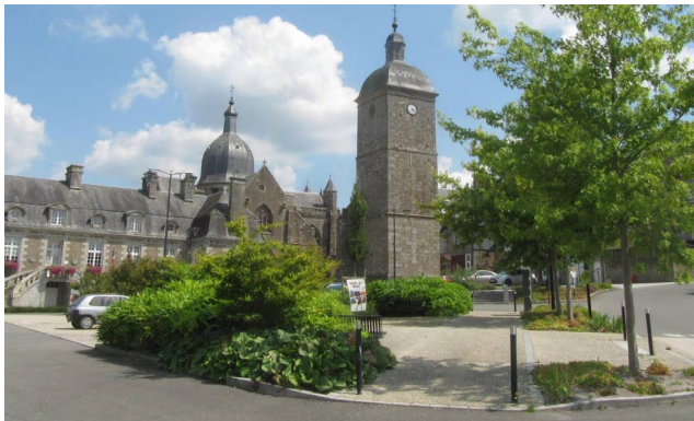
Noies de Sienne : L'aménagement et la revitalisation du bourg de Saint-Sever : restructuration des espaces publics, végétalisation et désimperméabilisation des sols, notamment des espaces de stationnement.
