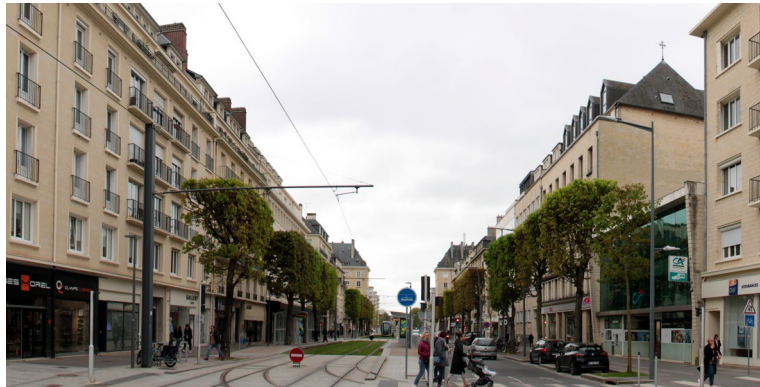
Avenue du Six Juin, axe central où passe le tramway, bordé par des immeubles de la reconstruction.
