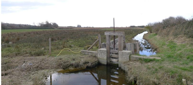
Les marais sont dépendants d'un système de canalisation et de vannes de vidange appelé localement «noc».
