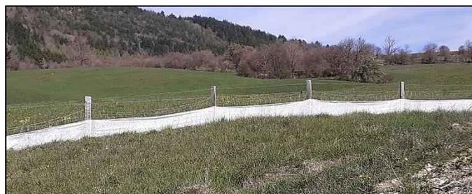
Figure 91 : Exemple de barrière anti-intrusion petite faune
