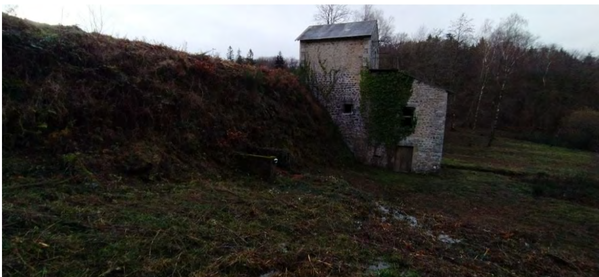
Figure 42 : Digue de l'étang des Chênes rive droite, coursier et évacuation centrale passant dans l'ancienne turbine
