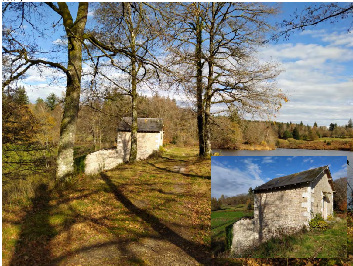
Figure 10 : Bâtiment abritant une turbine électrique sur la digue de l'étang des Chênes (vue générale et détail)
