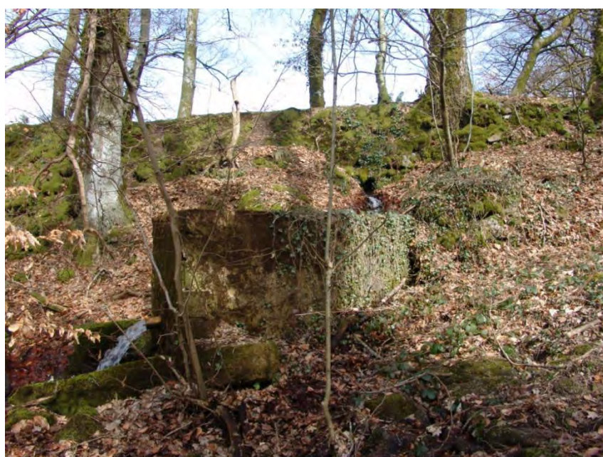
Figure 46 : Structure en pierre et béton à l'aval du Petit étang des Chênes
