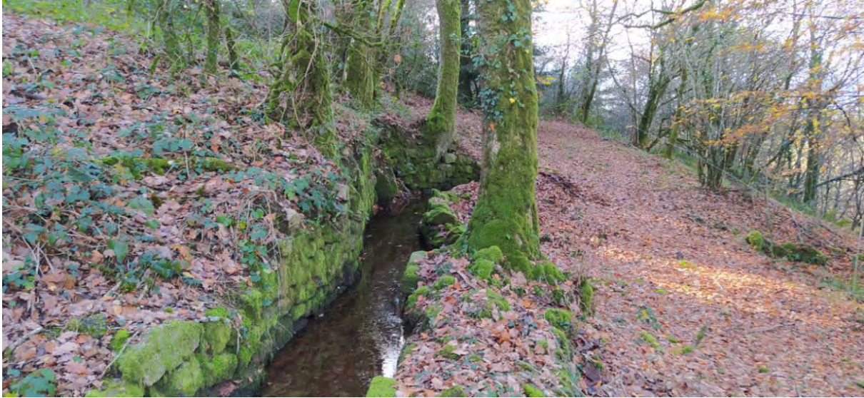
Figure 47 : Déversoir empierré rive gauche du Petit étang des Chênes
