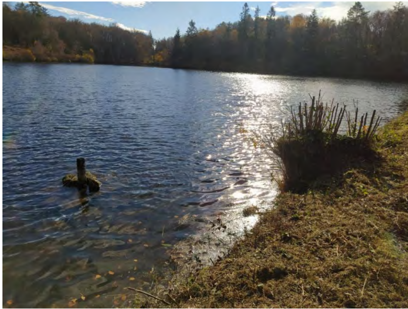
Figure 43 : Digue de l'étang des Chênes et vanne haute
