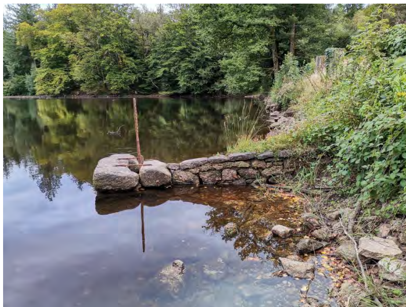
Figure 39 : Vanne haute et digue amont de l'étang des Sauvages
