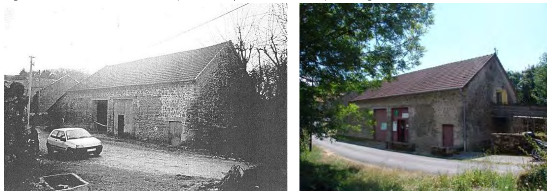
Figure 78 : Maison de la réserve (avant et après restauration), Sauvagnac
