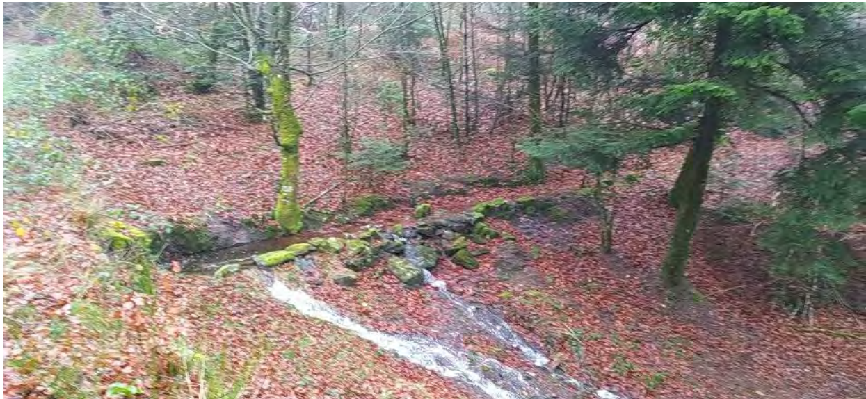
Figure 41 : Déversoir gauche empierré de l'étang des Sauvages
