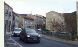
Vue montante sur le viaduc « S » de la RN116
