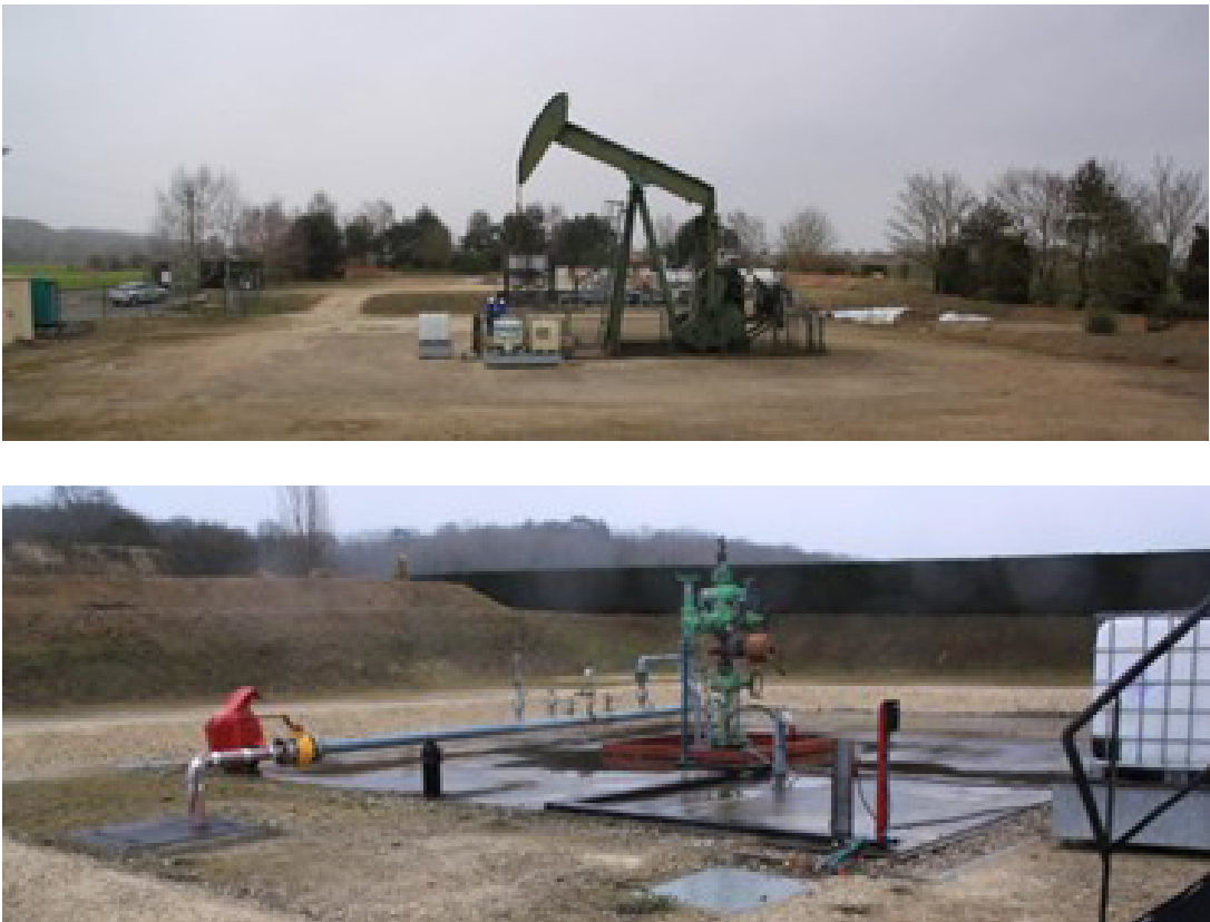
Figure 3 : pompe à balancier (en haut) et pompe centrifuge immergée (en bas) (source : dossier d'Itteville)
