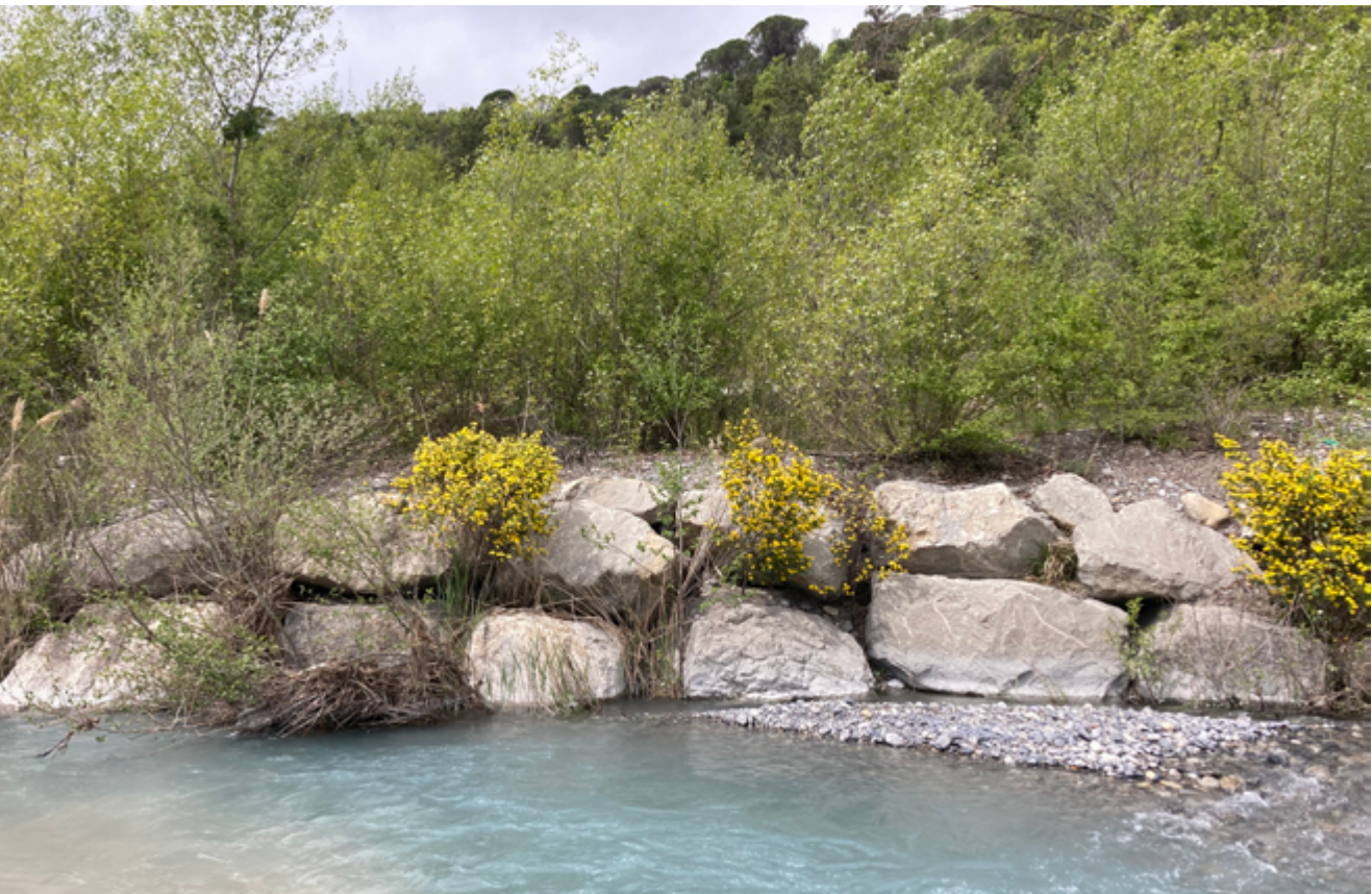
Confortement berges bléone
