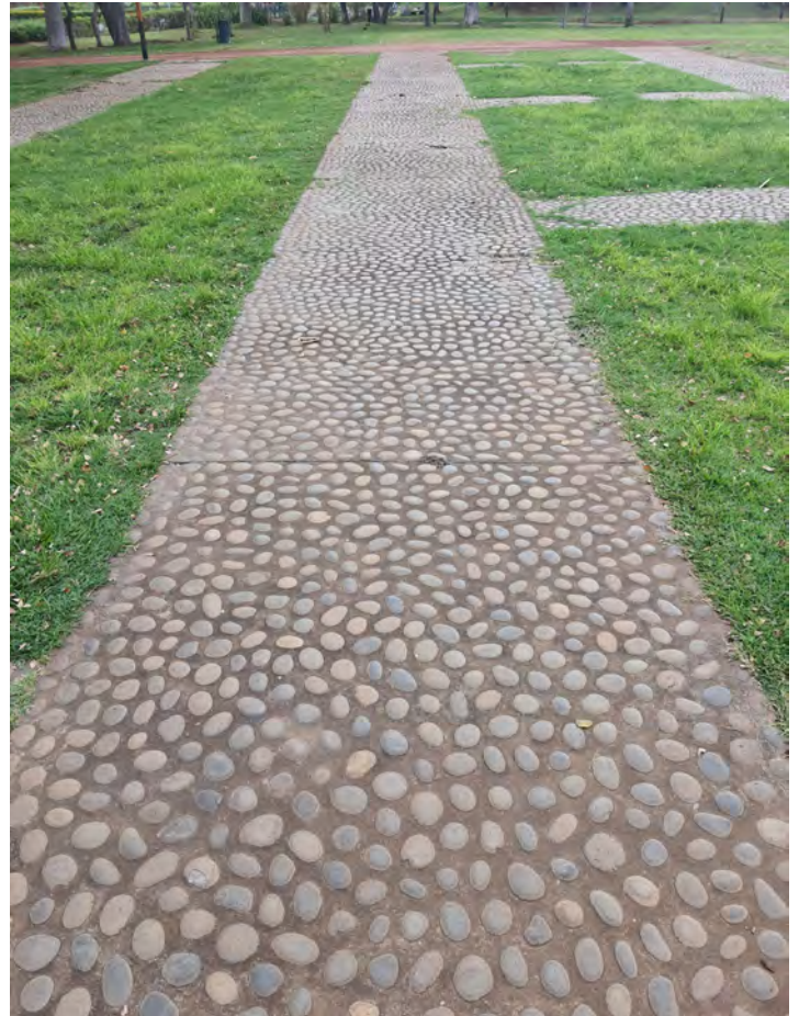
Ré aménagement du parc boisé au Port Les galets apparents intégrés au béton proposent un cheminement stable et accessible aux personnes à mobilité réduite.
