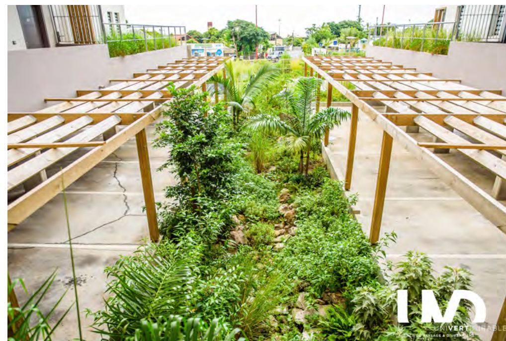
Stationnements de la résidence des Jasmins à La Possession Une noue centrale récupère les eaux de pluie et favorise leur infiltration. Les stationnements sont ombragés par une pergola brise-soleil. Depuis les logements, la vue sur les stationnements est atténuée.
