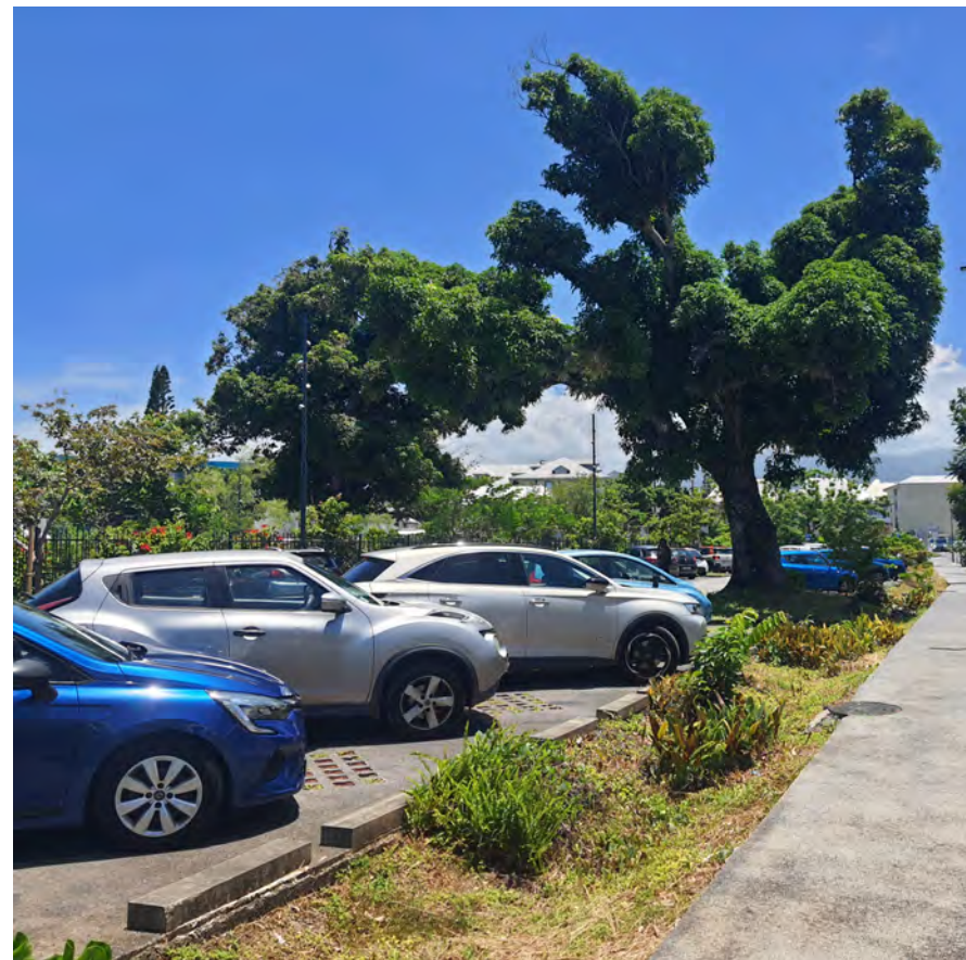
Aménagement du parking Lacaussade à Saint-André La végétation est installée dans une noue, protégée par des bordures en béton.
