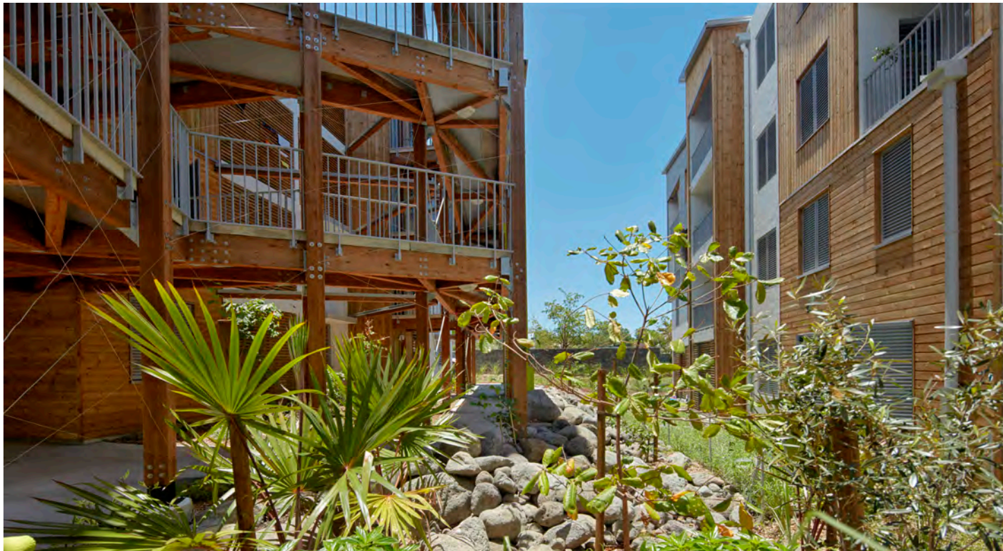
Opération les Mahots au Port Les noues végétalisées structurent la conception du projet. Aménagées entre les blocs d'habitation, elles servent de fil conducteur pour la gestion des eaux de pluie et l'aménagement paysager.
