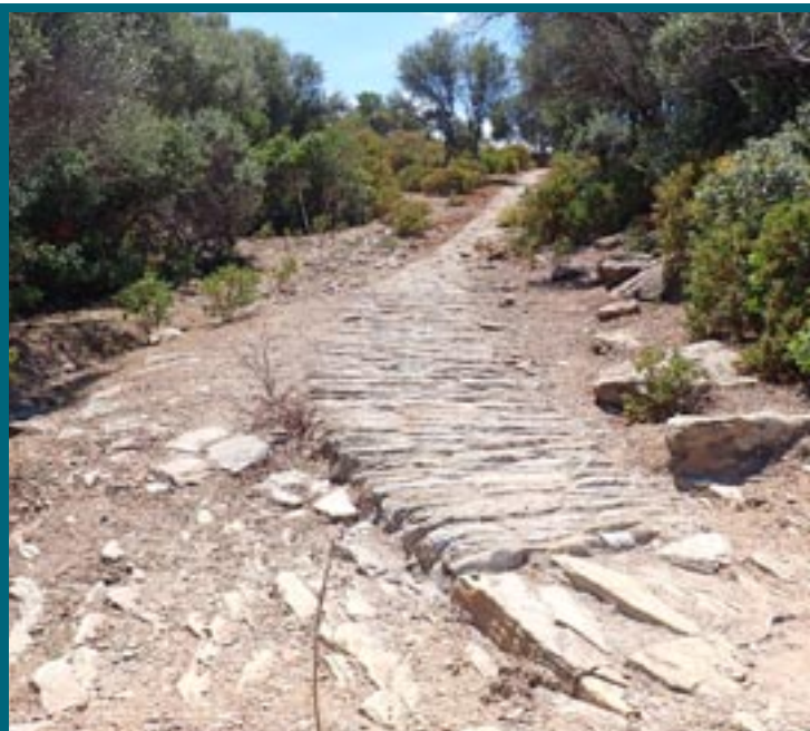
Construction d'ouvrages traditionnels en pierre sèche : Ricciata
