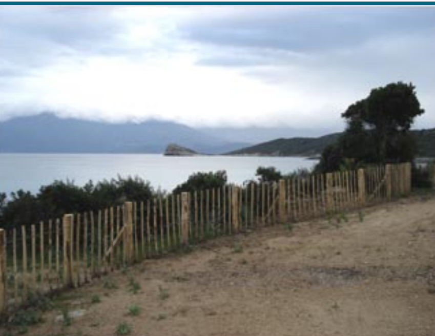
U Lotu. Restauration du sentier littoral entre le ponton d'accostage des navettes à passagers et la plage
