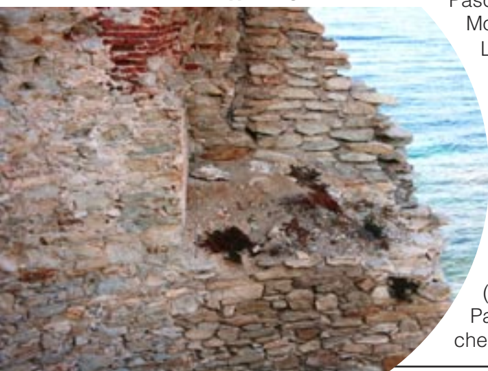
A Mortella. Détail de l'appareillage
