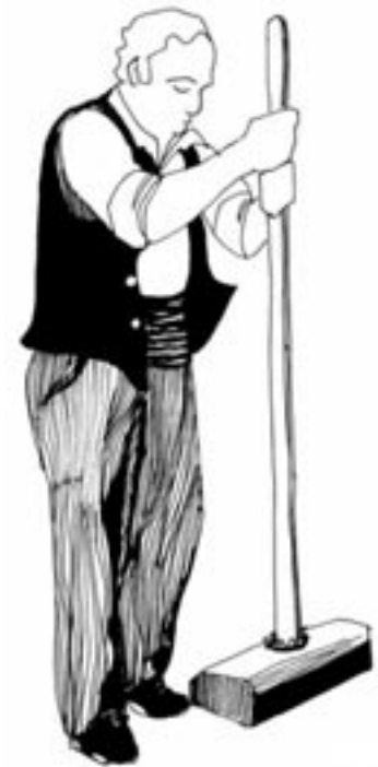
Battage ► du toit en terrasse
