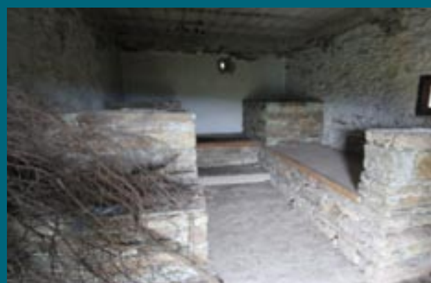
Aménagement des pagliaghji de Ghignu en refuge
