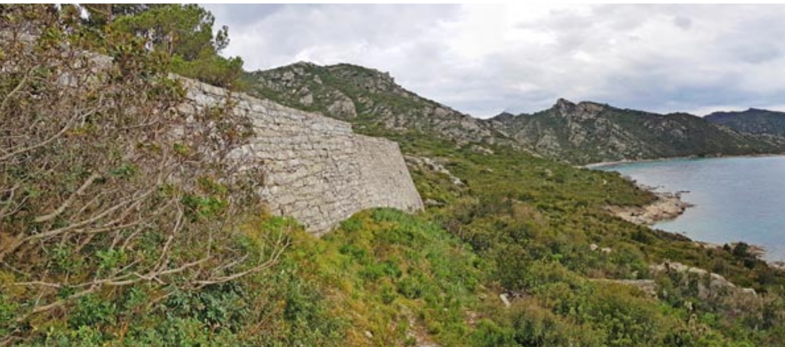
▼ Le mur d'enceinte du fortin de la punta di Cepu
