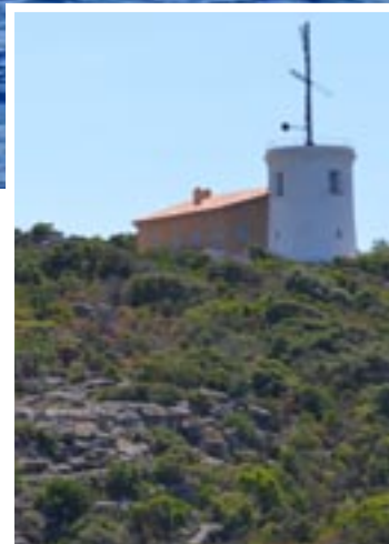
▲ L'ancien sémaphore construit en 1861 (restauré en 2015) auquel est accolé une maison d'habitation. Elle pouvait accueillir deux familles de veilleurs avec cuisine équipée et pompe à eau, latrines, four et potager.
