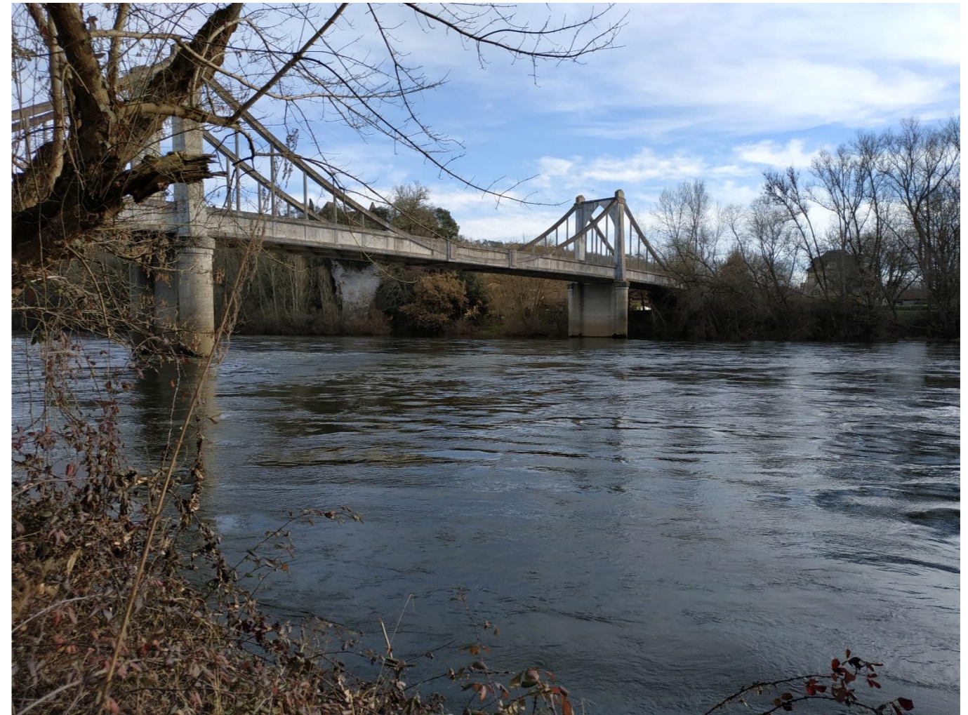
Pont de Groléjac (source : CERMECO)
