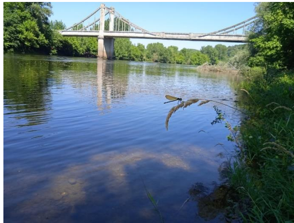
Figure 37: Substrat colmaté en aval du pont rive gauche (Groléjac, 2022) © ETEN environnement
