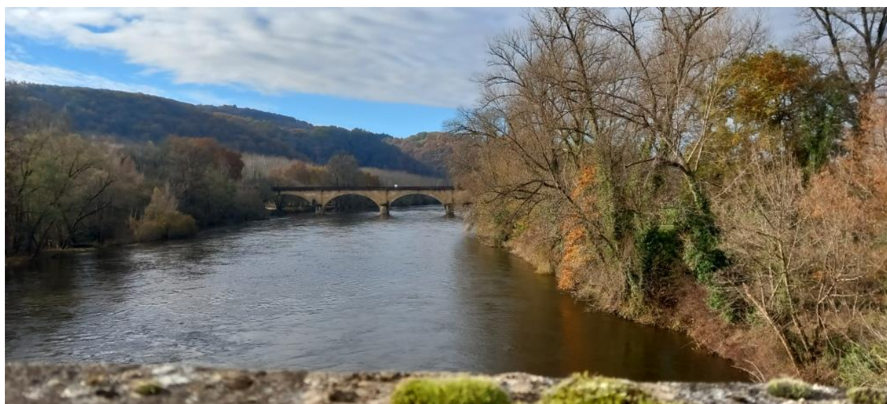
Figure 40 : Pont favorable à la mise en place des nids artificiels, vu depuis le pont concerné par les travaux © ETEN environnement
