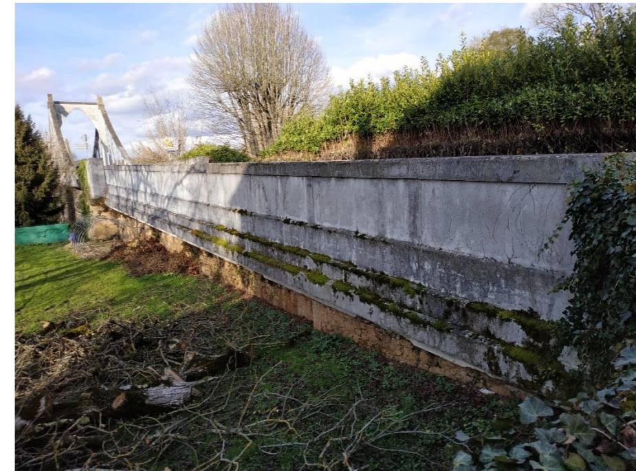
Photographie de l'ouvrage d'art vu depuis le bourg de Groléjac (source : CERMECO)
