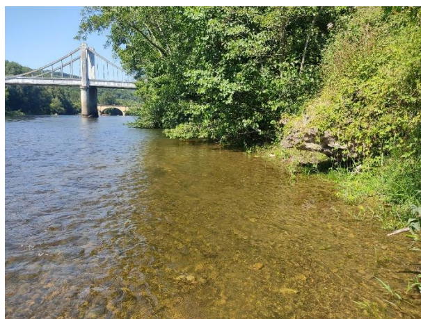
Figure 19 : Substrat hétérogène du lit (Groléjac, 2022) © ETEN Environnement
