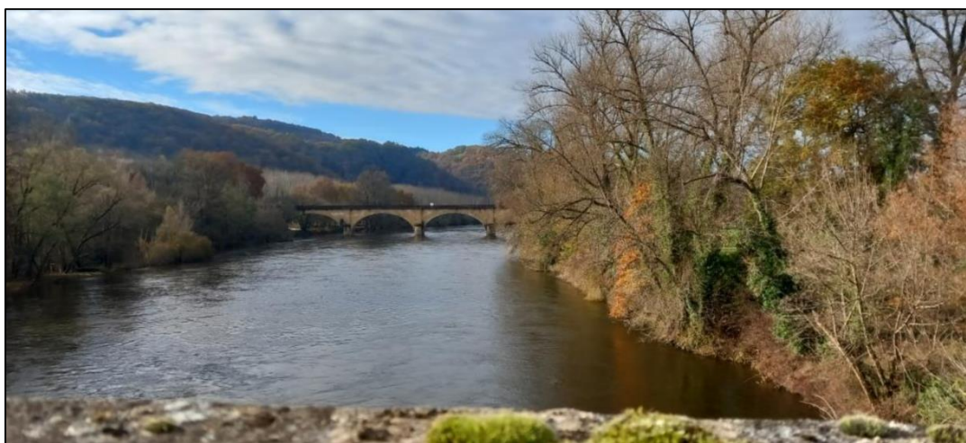
Figure 37 : Pont favorable à la mise en place des nids artificiels, vu depuis le pont concerné par les travaux (Source : ETEN Environnement)
