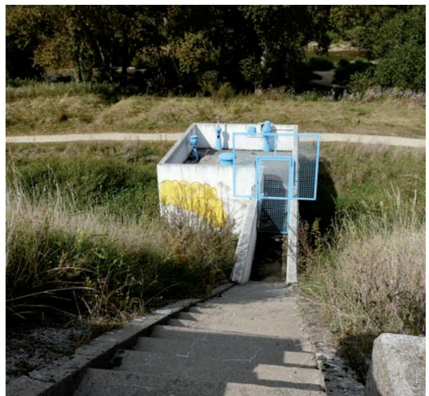
Fig. 201 : Local technique en pied de digue. L'escalier est entièrement refait en béton.
