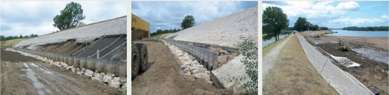
Fig. 202 : Travaux de confortement de la digue à Combleux, Loiret : Mise en place d'enrochements dissimulant les palplanches et reconstruction du perré dégradé.
