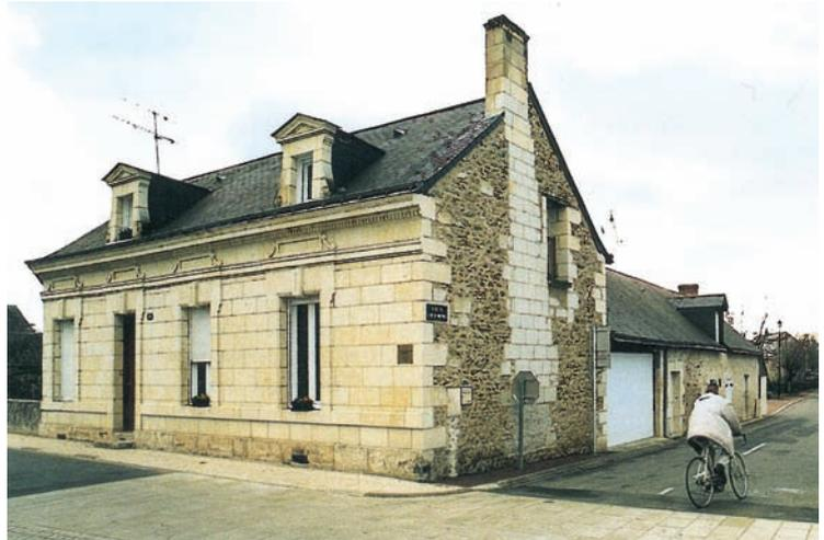
Fig. 28 : L'emploi des matériaux de construction tels que le tuffeau et l'ardoise permet la multiplication des décors.
