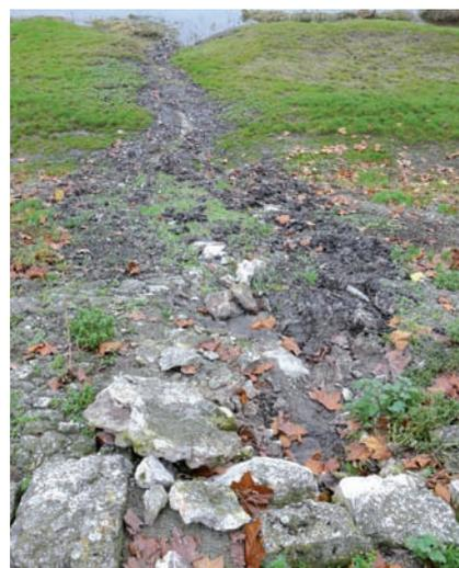
Fig. 41 : Rejet de canalisation érodant et dégradant le pavage.
