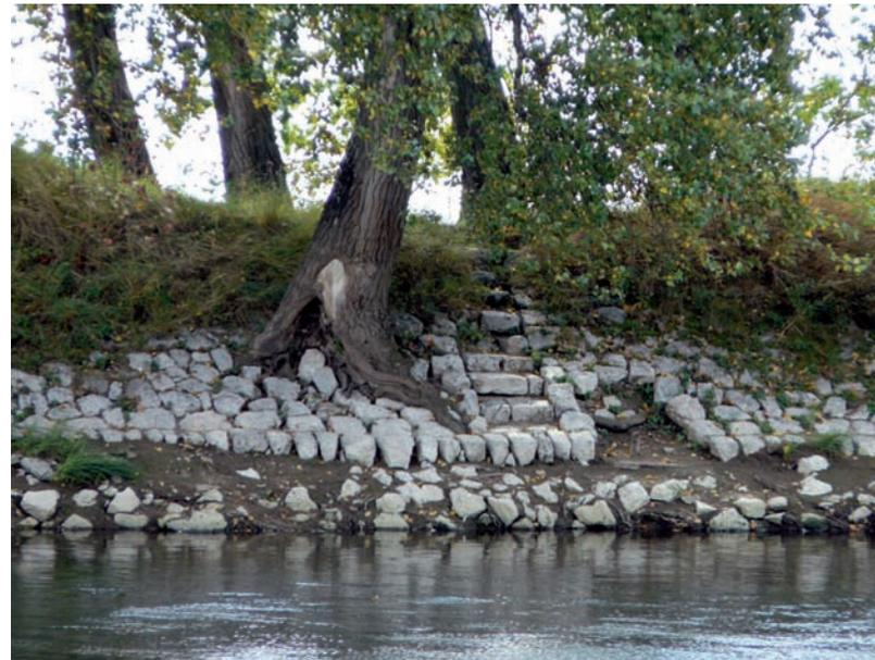
Fig. 200 : Dégradation d'un duit par développement d'une végétation non maîtrisée.
