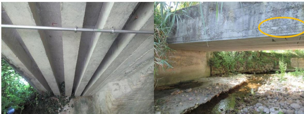
Figure 12 : à.g. tablier de pont non favorable et à.d. tablier favorable présentant des fissures (en orange)
