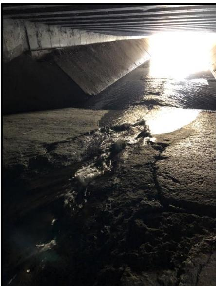
Figure 6. Chute, en amont de la sortie de l'OH enterré
