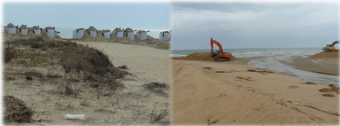
Figure 47 : Pose de big-bags pour fermer la passe du secteur des Violettes et pelles mécaniques en action pour fermer une autre passe en recréant un cordon dunaire ex nihilo.
