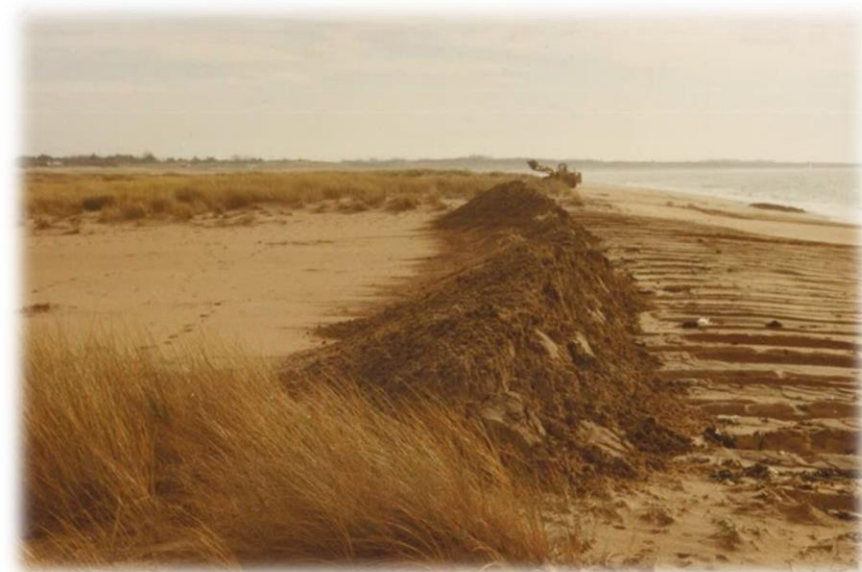
Figure 43 : 1980 - novembre – Colmatage d'une des quatre brèches de la tempête du 24 octobre 1980. On notera la faible hauteur du cordon dunaire à cette époque (Déat, 1995).
