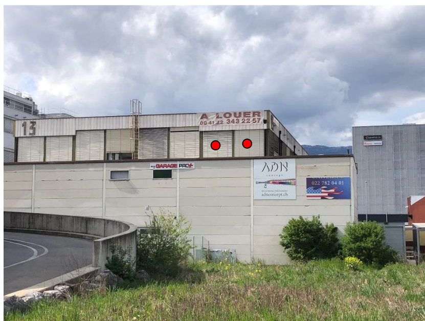
Figure 28 : Locaux situés 13, rue du Pré-de-la Fontaine (en rouge les récepteurs considérés pour les calculs) – actuellement non occupés.
