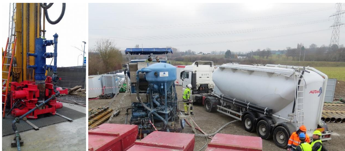
Figure 8: Opération de cimentation en circuit fermé sous pression pour la section Tertiaire de GEo-01.
