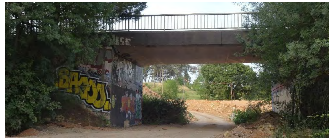
FIGURE 49 : PONT UTILISE COMME GITE PAR LA PIPISTRELLE PYGMEE (A. RAULINE-MOUGEOT, EGIS, 14/06/2022)
