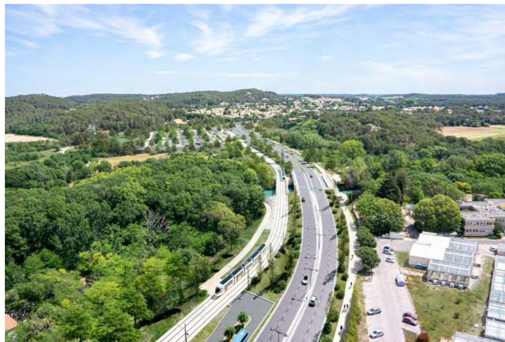
FIGURE 36 : VUE AERIEENNE DE LA STATION MONTFERRIER VERS GIRAC
