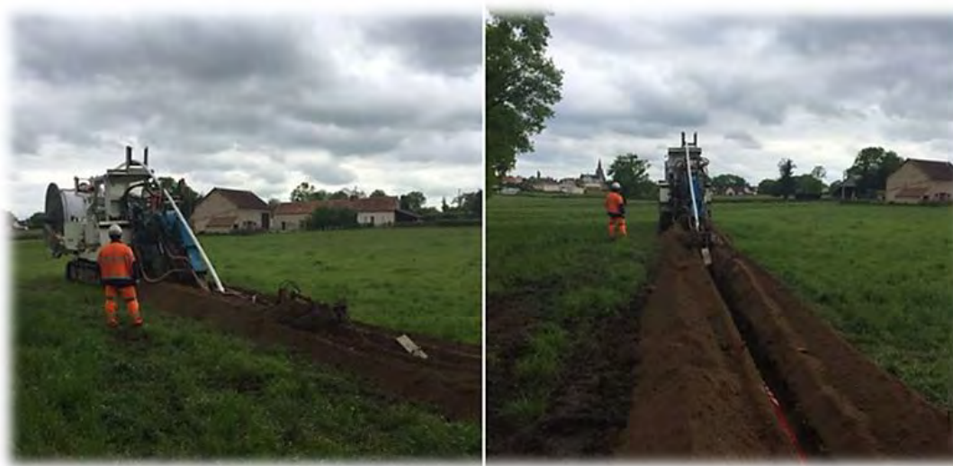
Figure 21 : Exemple de chantier d'enfouissement d'un réseau électrique en terres agricoles (source : Cegelec infra)
