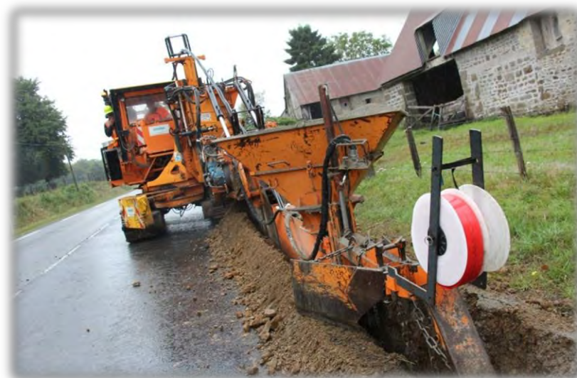
Photo 9 : Illustration d'un forage dirigé pour l'enterrement d'une ligne électrique le long d'une route
