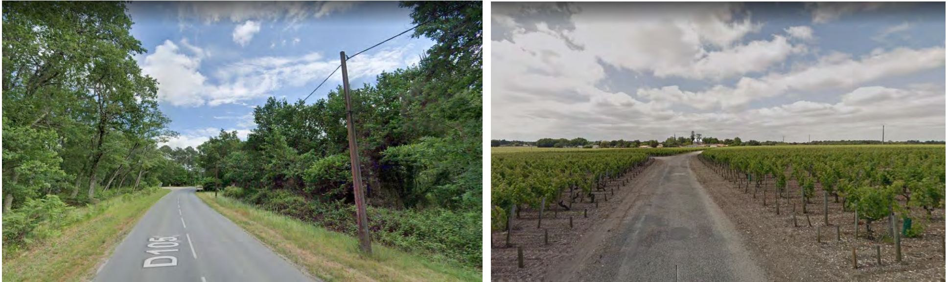
Photo 11 : Prises de vues de la chaussée au droit du tracé potentiel de raccordement électrique
