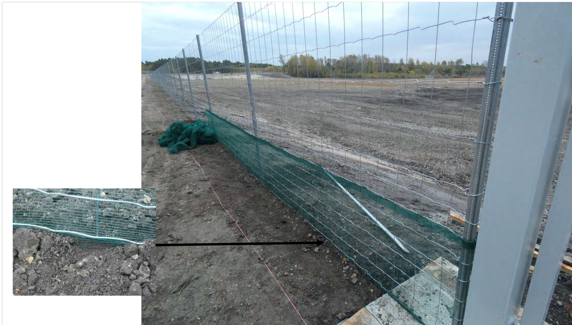
Photo 12 : Exemple d'installation d'une barrière à batraciens au pied d'une clôture à maille large avant un chantier de construction de parc
