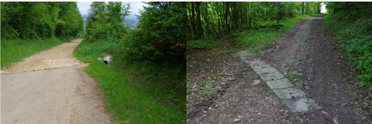
Collecteurs des eaux de ruissellement le long dit du chemin de haut bois.
