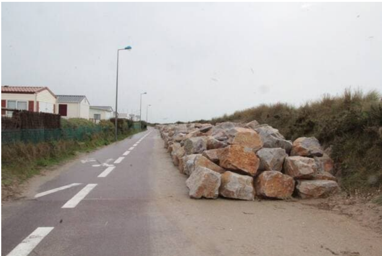
Des roches ont été installées en urgence sur la route, le long de la dune, pour protéger les deux campings menacés par les submersions marines. | OUEST-FRANCE
