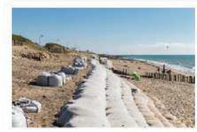
Big bags en géotextile à Gouville-sur-Mer (29/08/16 © photo Thierry Houyel)
