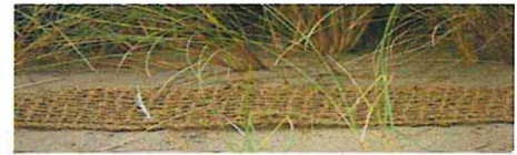
Filet anti-érosion en fibres de coco et plantation d'oysters - © Cerema
