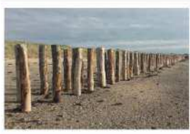
Pieux hydrauliques à Agon-Coutainville (11/10/17 © photo Pays de Coutances)
