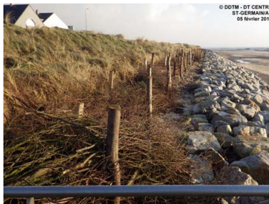
Confortement dunaire en sommet d'encochement à Saint-Germain-sur-Ay © DDTM 50
