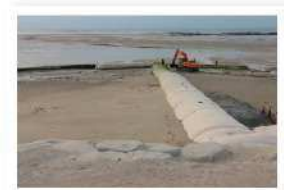
Epi géotextile en « T » à Gouville-sur-Mer (06/12/17 © photo Pays de Coutances)
