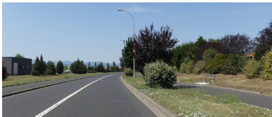
Mobilité douce isolée de la voirie, intégrée dans un espace planté, en limite de quartier résidentiel et d'espace d'activité. Forte végétalisation des abords.
