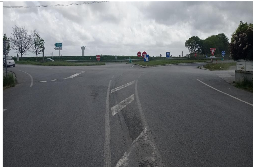
Photographie 2 : Échangeur de Kériel vue depuis la route communale (source : Ingérop, 05/05/2023)
