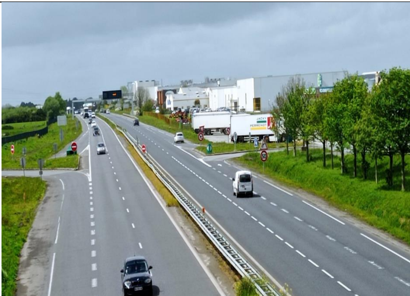
Photographie 1 : Échangeur existant de Kériel (source : Ingérop, 05/05/2023)
