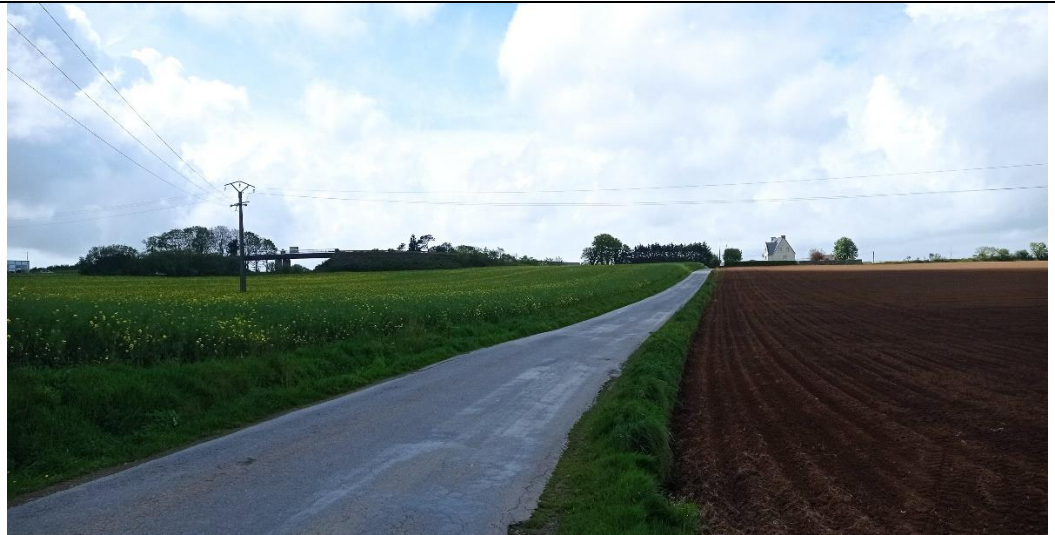
Photographie 6 : Voie communale de raccordement du futur échangeur (source : Ingérop, 05/05/2023)
