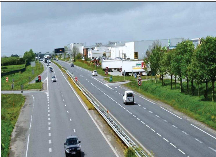
Photographie 1 : Échangeur existant de Kériel (source : Ingérop, 05/05/2023)
