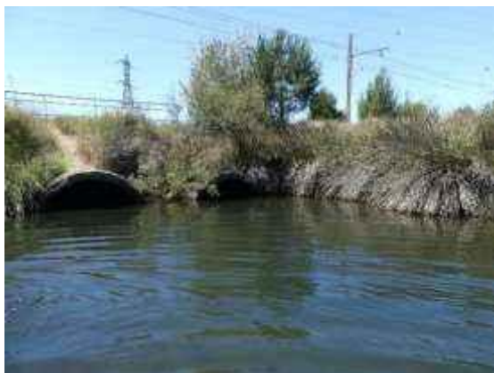
Vue des buses depuis l'aval
