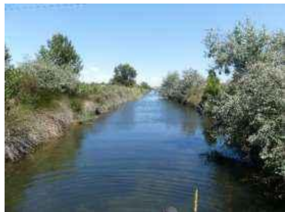
Vue générale du canal en sortie des buses
