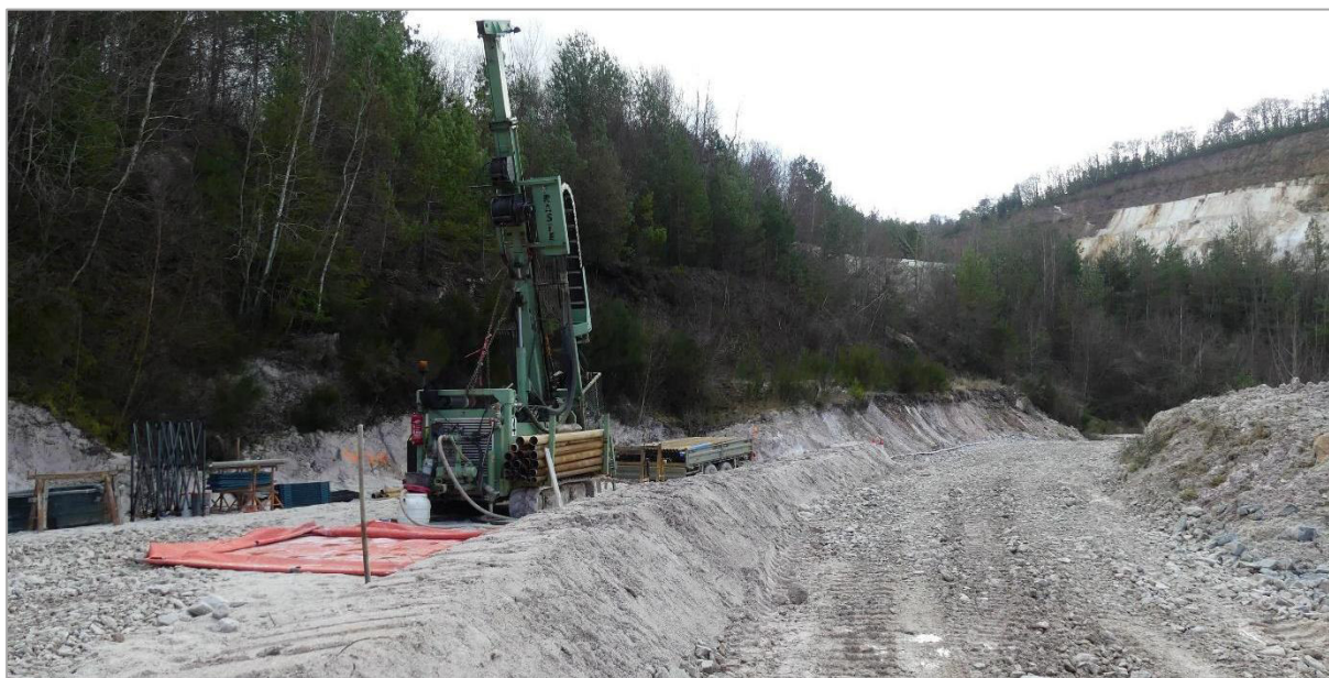
Illustration : Foreuse et matériel en place pour la campagne de sondages Phase 1, le long d'une piste existante – Echassières février 2022 - source photographique : Mica Environnement
