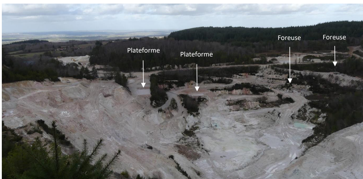
Echassières février 2022 - source photographique : Mica Environnement
