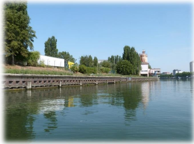
Figure 12 : Berges composées de palplanches sur la Seine à Vitry-sur-Seine le 25/07/2019 (Photo : DUBOST Environnement)
