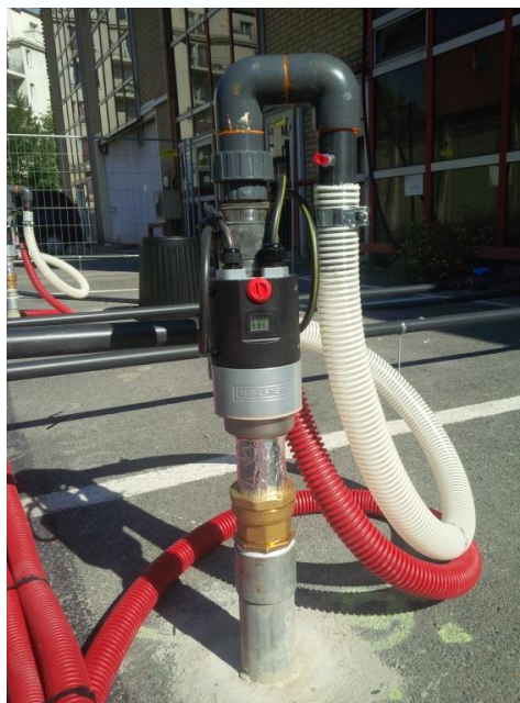
Figure 30 : principe de chauffe des sols (venting chauffé simple)
