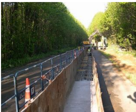
Pendant les travaux
