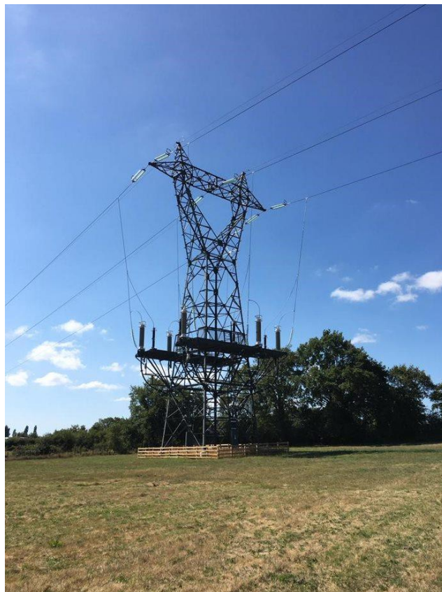
Exemple de pylône aéro-souterrain
