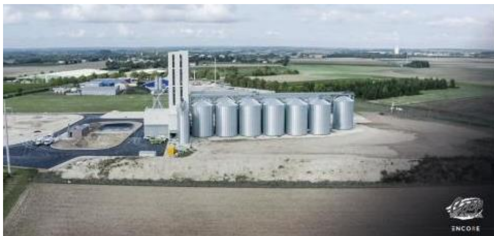
Le site de stockage agricole de Blanzac-Lès-Matha
