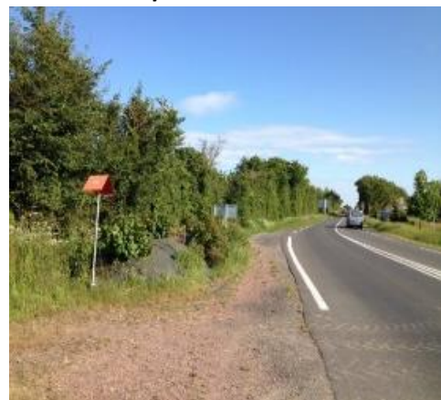
Après les travaux
