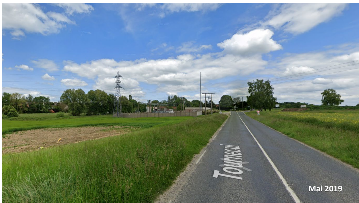
Vue éloignée en arrivant de l'ouest
