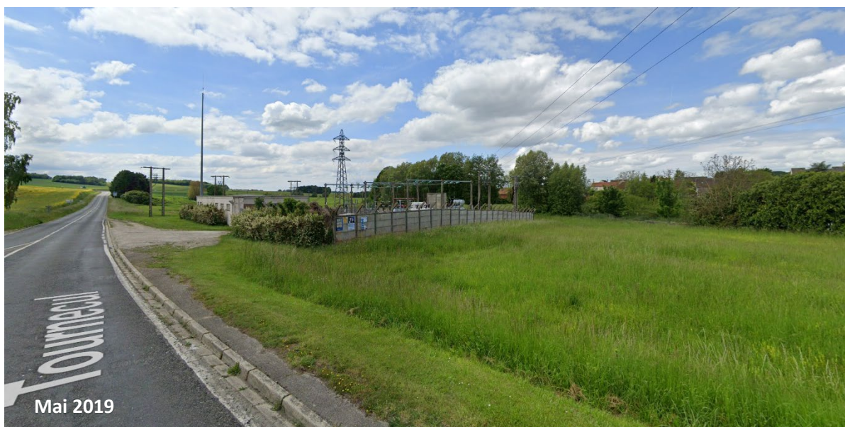
Vue éloignée sur le poste en arrivant par l'est
