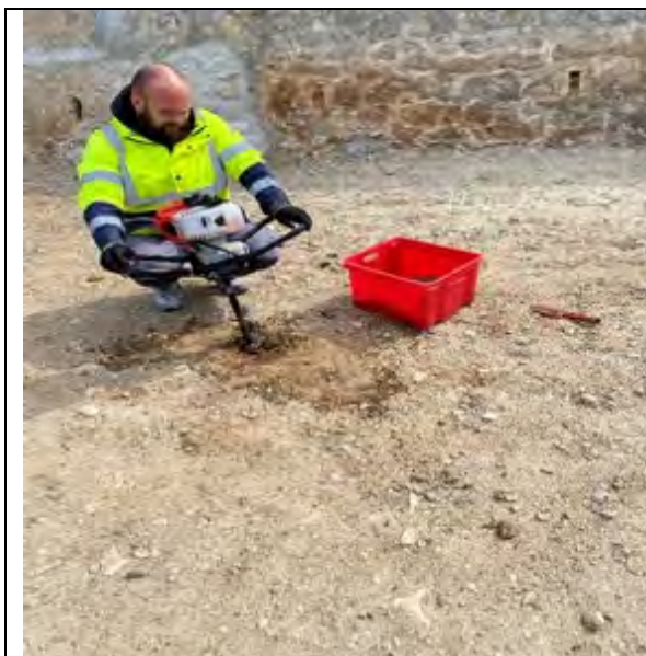
Opération de Forage
