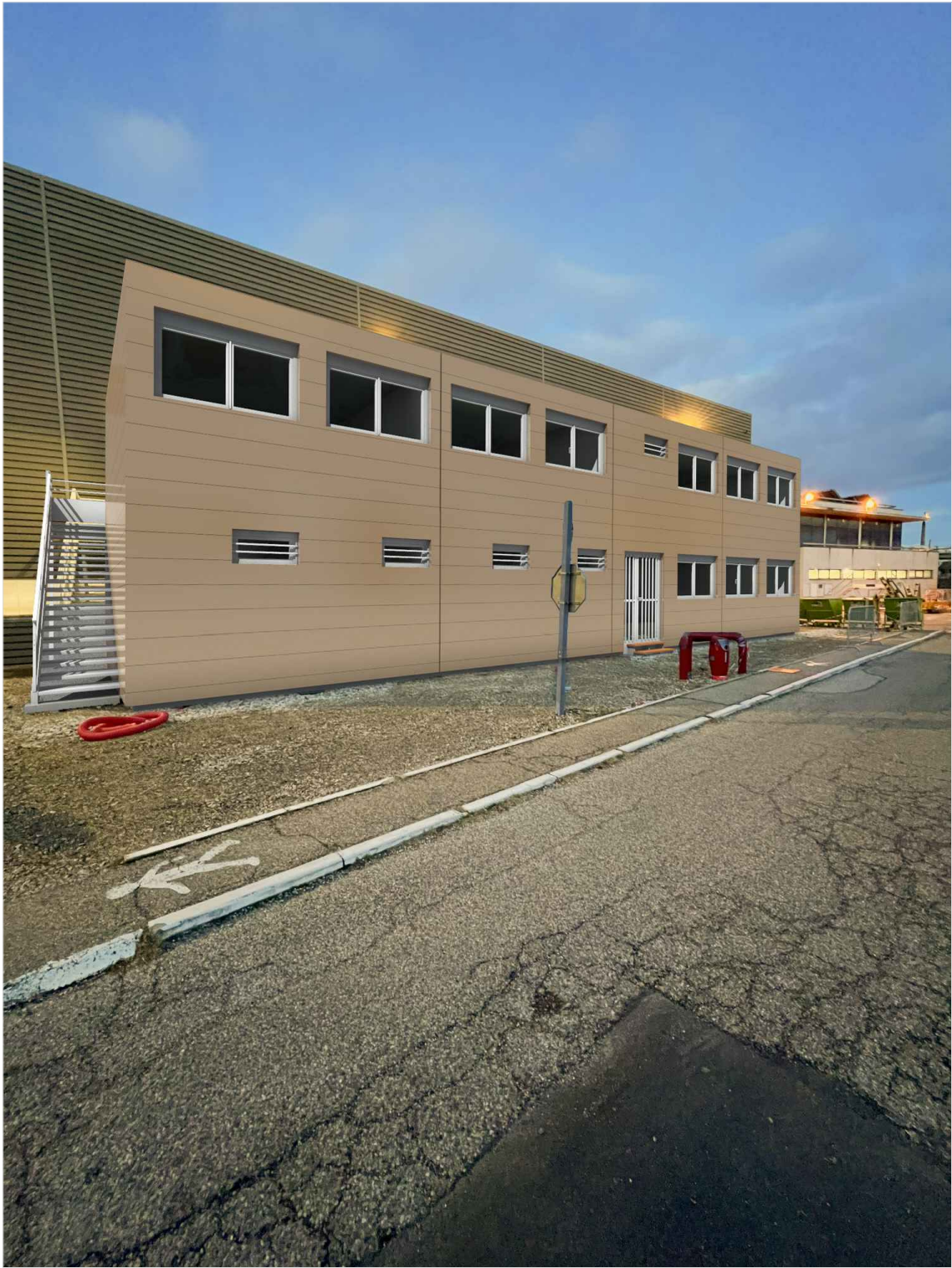
PC 6 VUE 1 APRES TRAVAUX Vue en direction de l'Est
