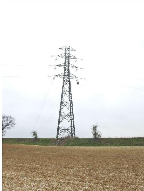
**Figure 5 : Exemple de support pour la réalisation d'une entrée en coupure**
