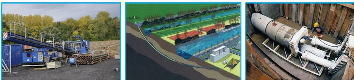
Figure 5 : Machine pour la réalisation de forages dirigés (photo de gauche et du centre) ; Micro-tunnelier (photo de droite)
