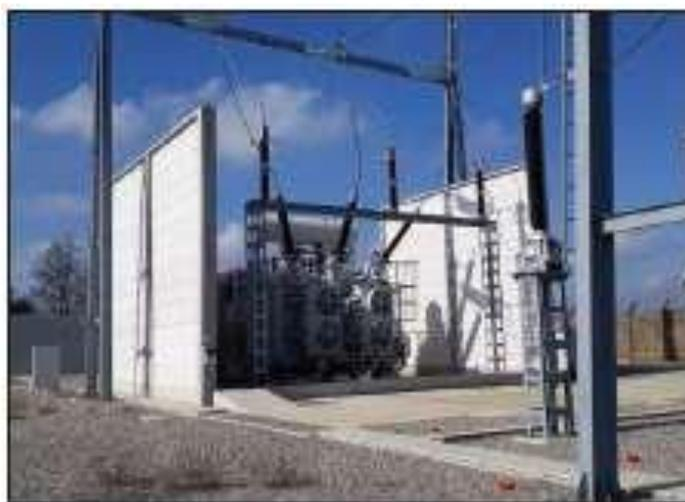
**Figure 8 : Transformateur dans un poste très haute tension**
