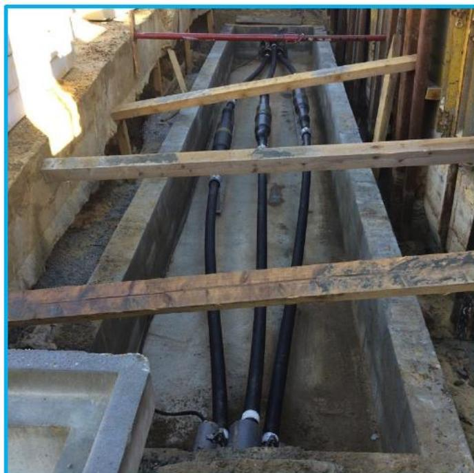
Figure 3 : Chambres de jonction de 1,40m de profondeur et de 2m de largeur
