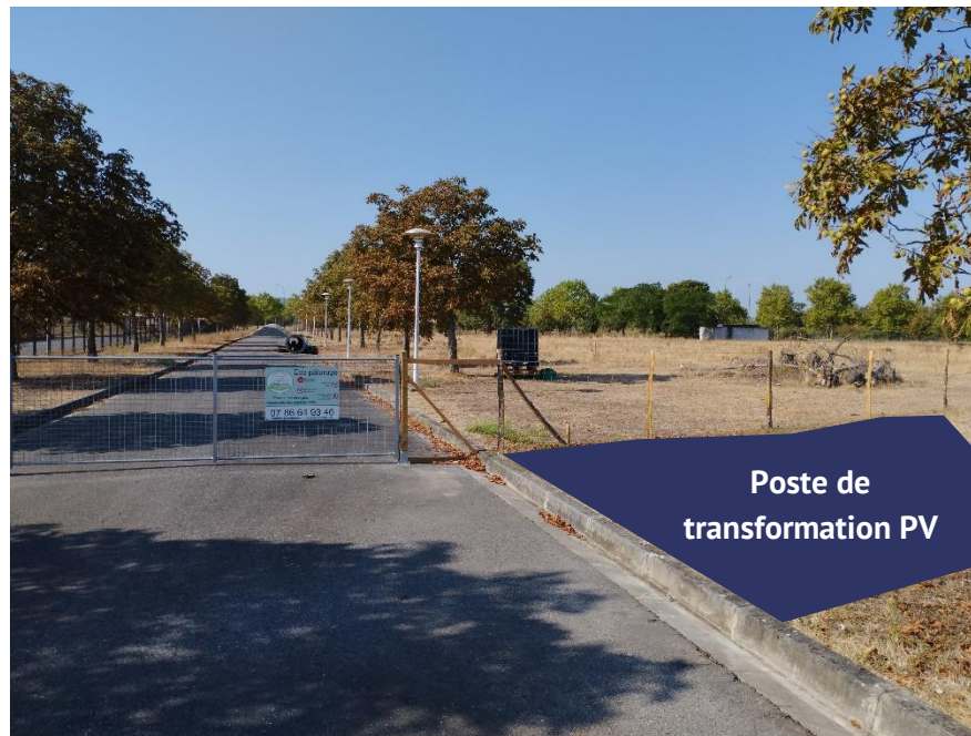
Figure 19 Emplacement du futur poste de transformation PV - zone 3
