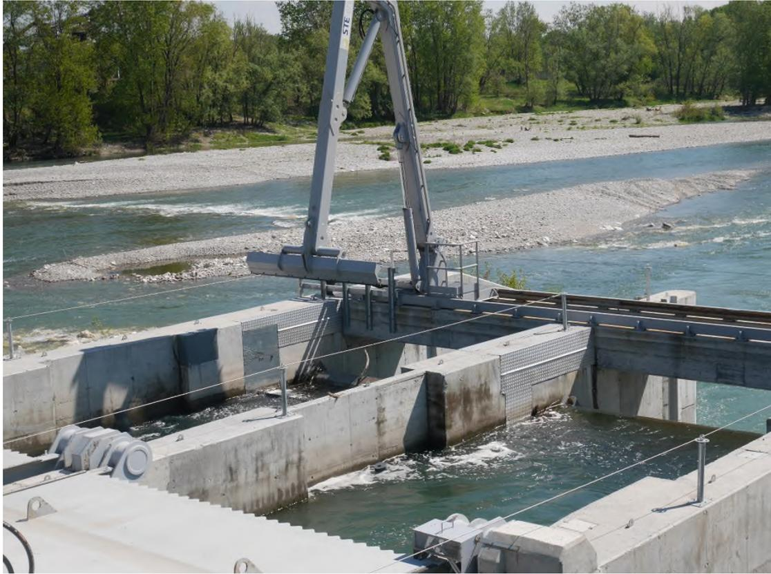
*Figure 1 : Centrale VLH de Bisnate en Italie (2 turbines VLH)*
