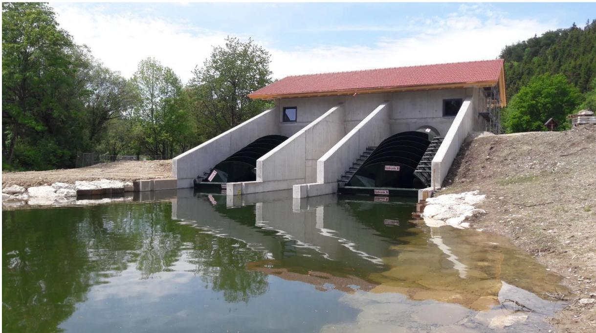
*Figure 2 : Centrale de Höllthal en Allemagne (2 vis de 4,3m de diamètre, source : VANDEZANDE)*
