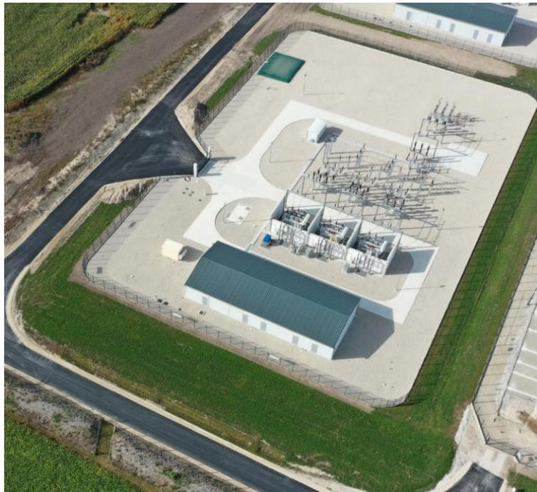
Figure 9 : Exemple d'un poste source 225 000 / 20 000 volts
